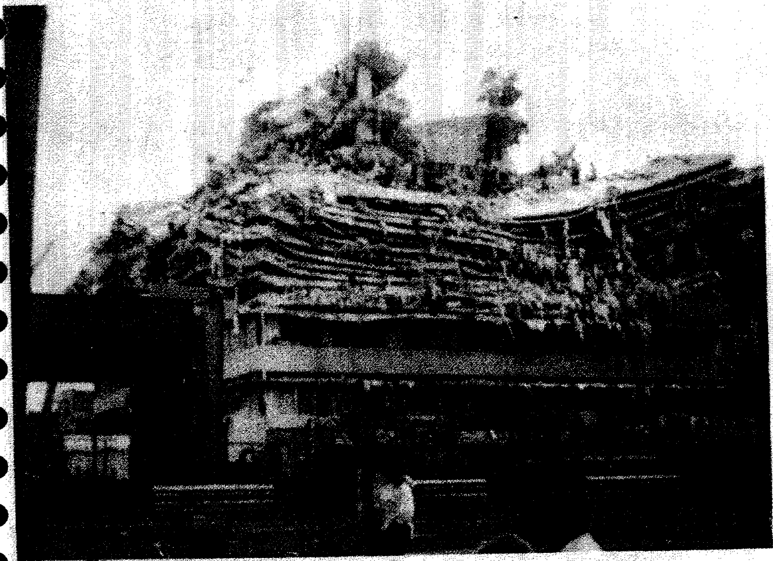
Fábrica de Confecciones, frente al metro de "San Antonio Abad". El edificio de 11 pisos al derrumbarse produjo el aplastamiento de cientos de cadáveres. Aún permanecen entre las ruinas los cuerpos de 30 trabajadores de la fábrica.
