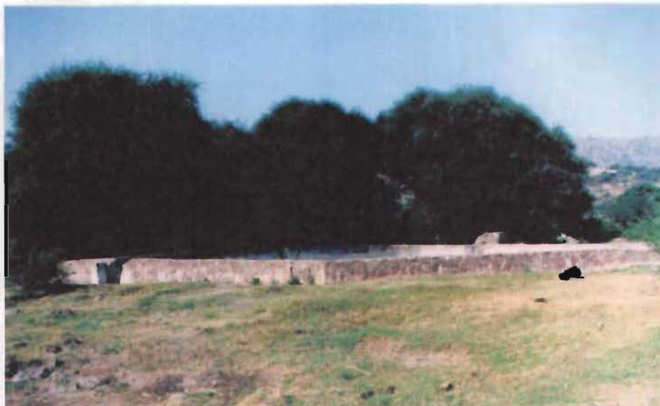
Figura 5.12 Manantial de Tequisquiapan, ubicado en el centroide de la cuenca donde convergen los tres sistemas de flujo. El manantial descargaba volúmenes importantes pero comenzó a secarse a mediados de los años 70's. El brocal mide 15 x 15 m.
