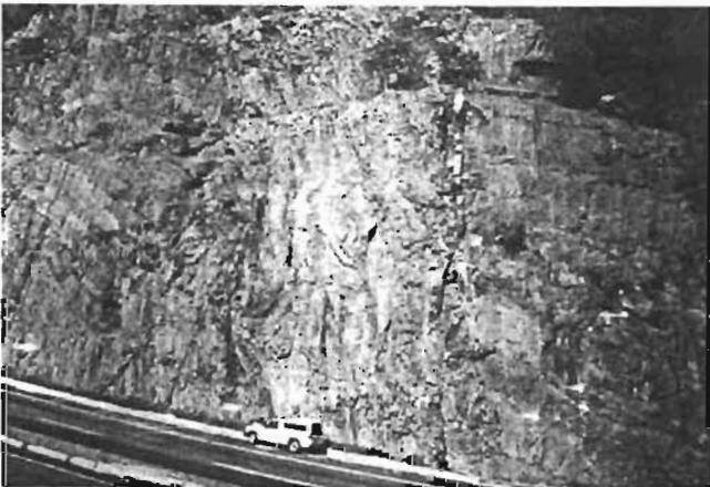
Figura 5.2b. Relación entre la zona de deformación subvertical y la estratificación en las calizas.
