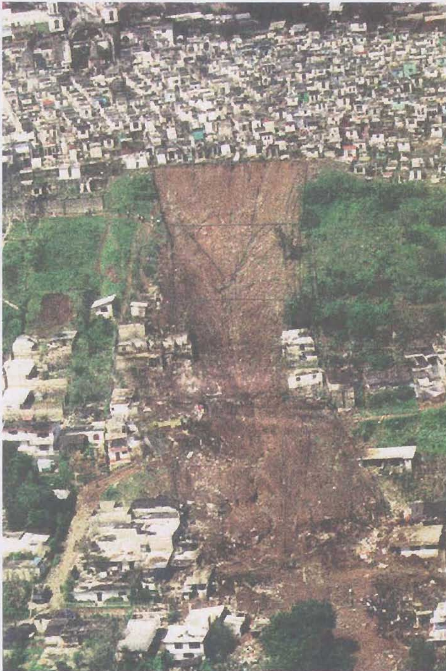
Figura 3.3 Vista aérea del deslizamiento en la Colonia La Aurora, Teziutlán Pue.
