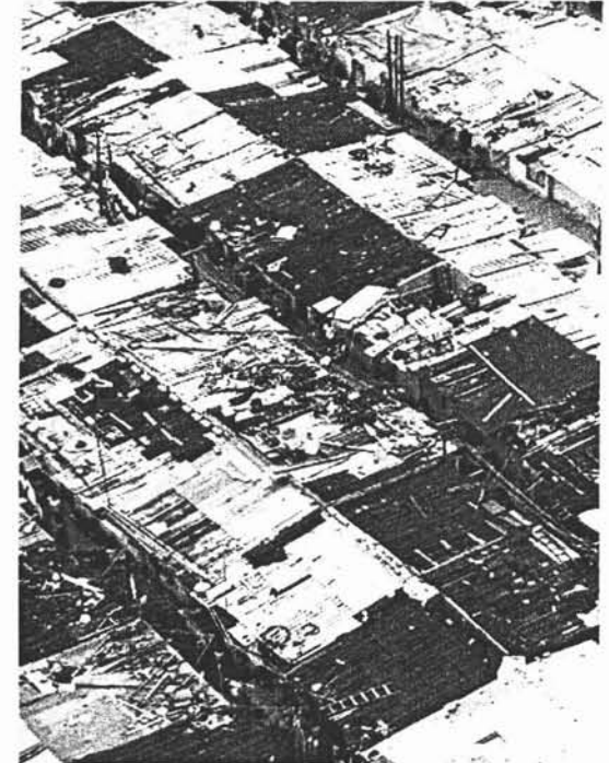
6. Vivienda informal (Paracaidistas), uno de los factores del crecimiento de la mancha urbana de la Ciudad de México.
