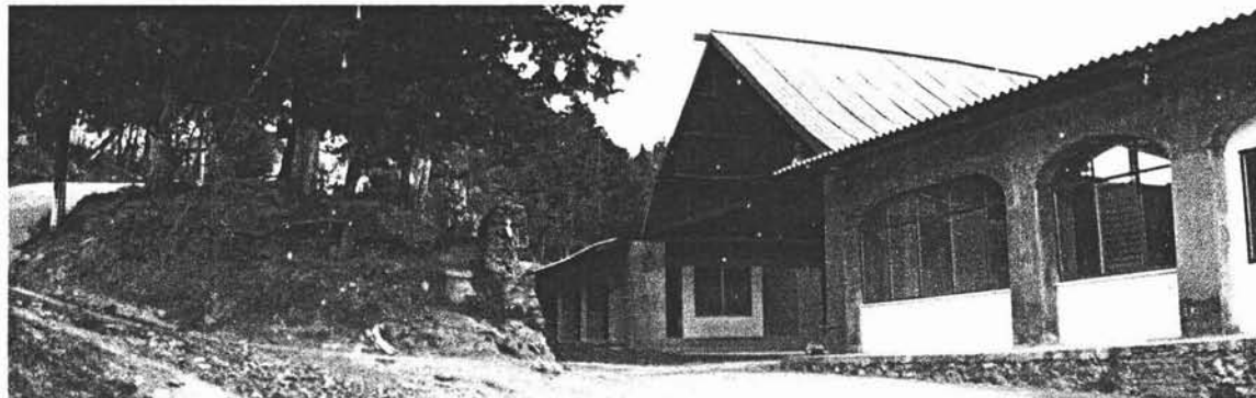
79. Fotos del parque Eco-arqueológico "Mazantepec" Ubicado en la parte Sur del Cerro del Judío.
