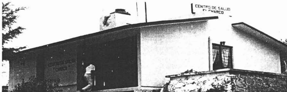
78. Foto del Centro de Salud, Ubicado en la parte Sur del Cerro del Judío.
