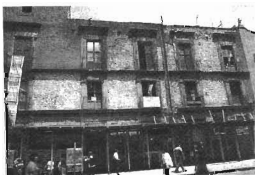
Fig. 22 Restauración en fachada 243
