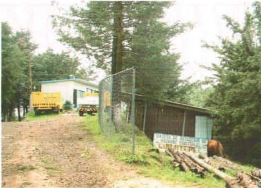
Caseta de detección de incendios forestales
