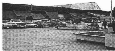
NAVE DE MANOJEO
