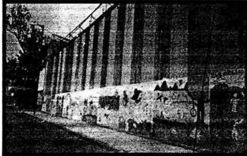
FIGURA 75 BARDA PERIMETRAL CANAL
