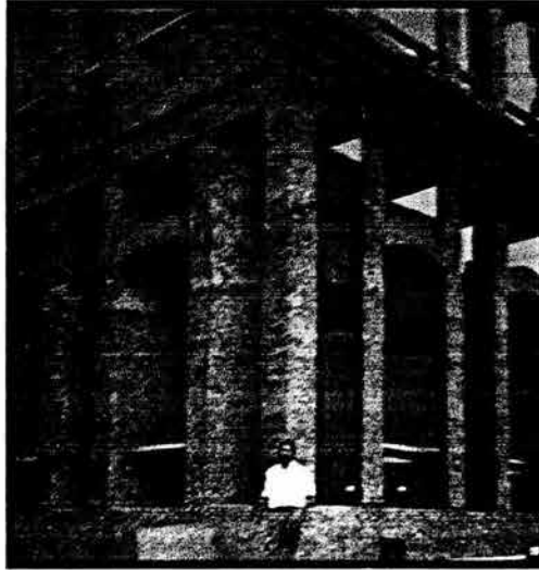
FACHADA 46 ESQUINA PROYECTO BANAMEX
