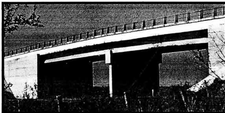
FIGURA 67 PUENTE SANTA RITA
