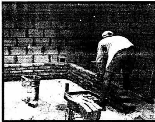
FIGURA 77 CONSTRUCCIÓN DE NUESVAS CELDAS
