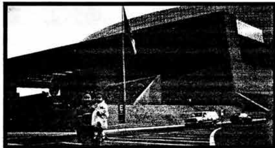
FIGURA 44 FACHADA AUDITORIO NACIONAL
