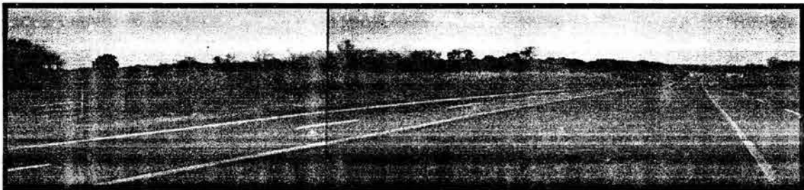
FIGURA 66 AUTOPISTA CÓRDOBA-VERACRUZ KM 68
