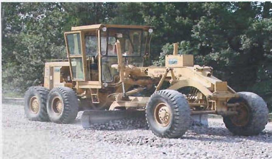
Fig 5.6 Enrasado del material con motoniveladora
