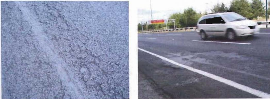
Fig 4.3 Agrietamiento en mapa y alisamiento de la superficie
