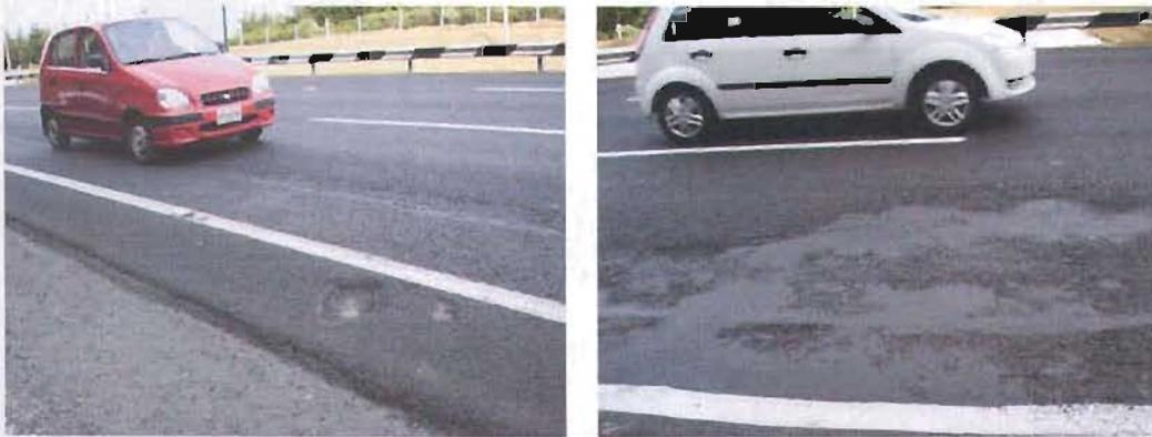
Fig 4.1 Desintegración de la superficie y Alisamiento de la superficie en carriles de proyecto
