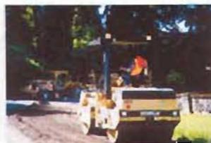
La mezcla se compacta hasta alcanzar el 96% de la densidad requerida por la prueba Proctor Standard (ASTM D558). La compactación se realiza normalmente con un rodillo liso-neumático-vibratorio. Seguido de un rodillo neumático para terminar la superficie. La compactación final debe tomar no más de 3 hrs desde la pasada inicial de la mezcla con cemento. La densidad en campo y el contenido de humedad son monitoreados con propósitos de calidad.
