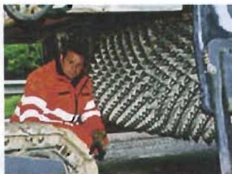
En algunas obras de menor relevancia, es todavía común observar como ciertos vehículos distribuyen sobre la superficie de contacto el cemento en forma de polvo a la espera del paso de la máquina recicladora. Esto en realidad no es muy recomendable pues **la dosificación** no es precisa y la acción del viento puede poner en peligro la salud de quienes participan en esta actividad.
