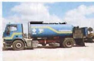
Fig. 5.11 Ejecución de riego de adherencia mediante camión cisterna
