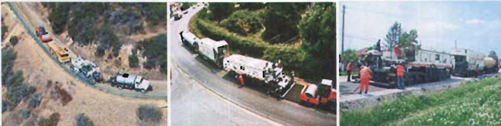
Fig 3.6 Conformación de Trenes de reciclaje en frío
