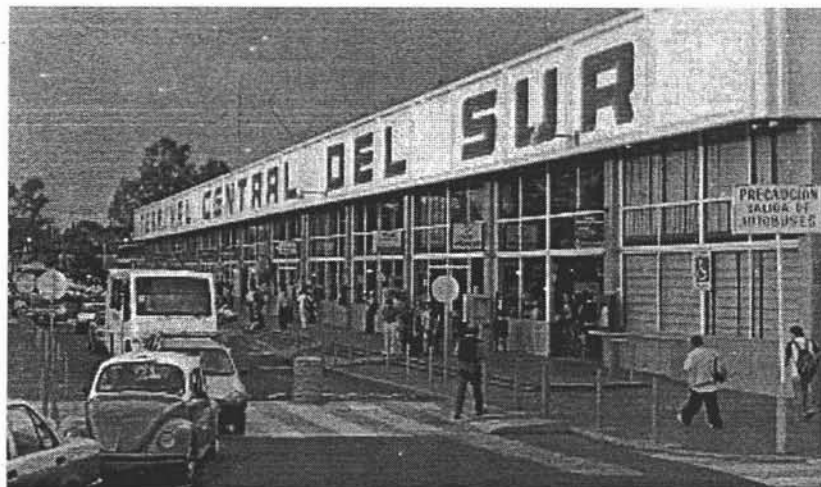
Foto 6. Terminal Central Camionera del Sur, Av. Taxqueña
