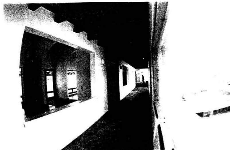
Vista de la circulación principal
