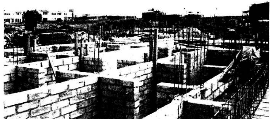
Muros de enrase
