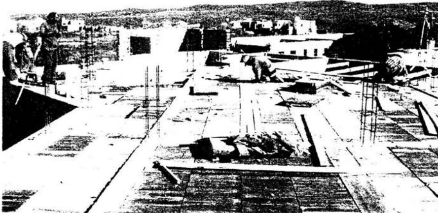
Cimbrado y armado de losa de entrepiso, trabes y cerramientos del nivel + 3.00.
