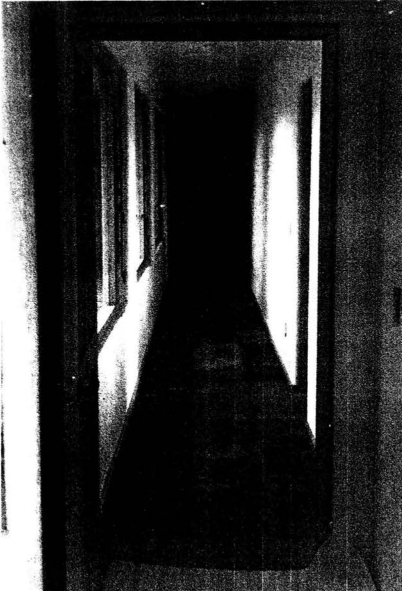
Vista del Pasillo Nivel +20
