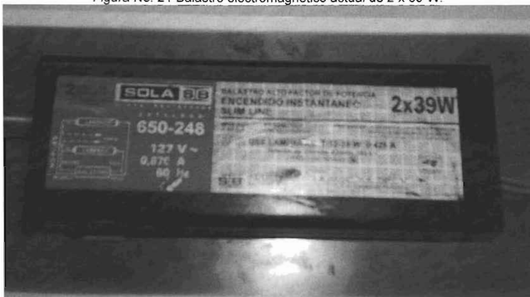
Figura No. 21 Balastro electromagnético actual de 2 x 39 W.
