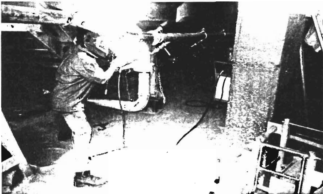
Figura 12. Soldando componentes de descarga.
