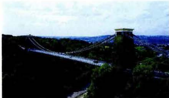
Puente colgante, Bristol, 1829-1864
