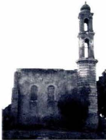
CAPILLA FACHADA LATERAL Foto del INAH de Guanajuato , 1986
