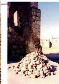
Limpieza de restos en la cruja sur
