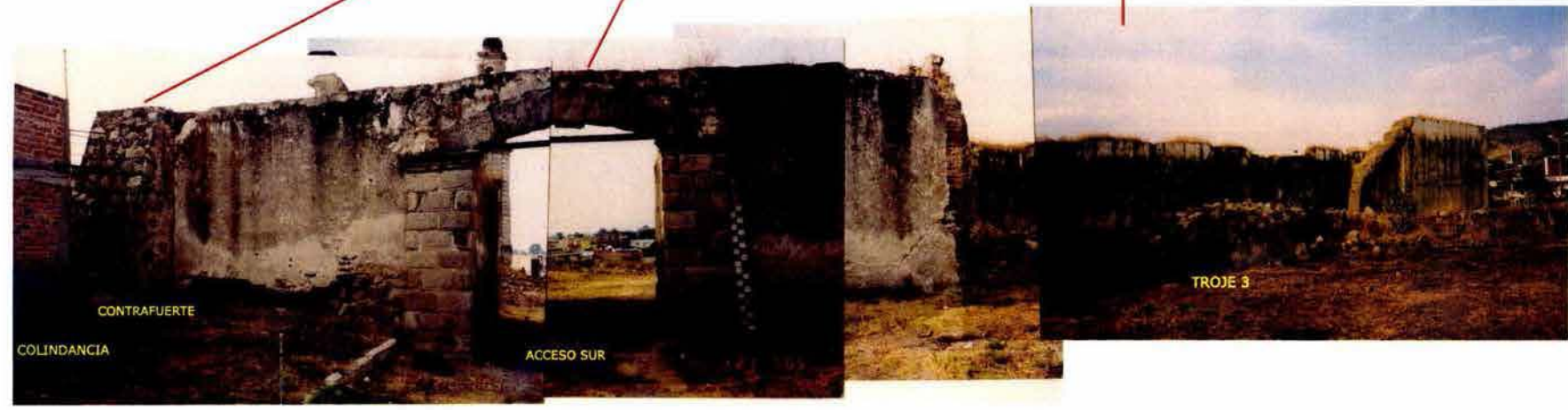
Acceso Sur sobre la calle San Luis
