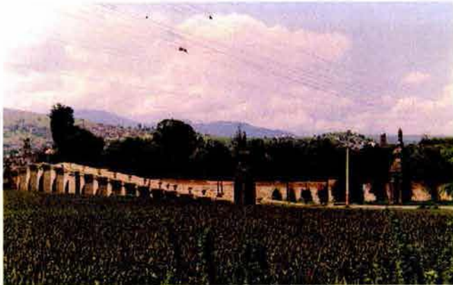
El puente ubicado en la entrada de Acámbaro, 1998
