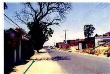
1. El área de peatones esta desprotegida y no se diferencia del arroyo.
