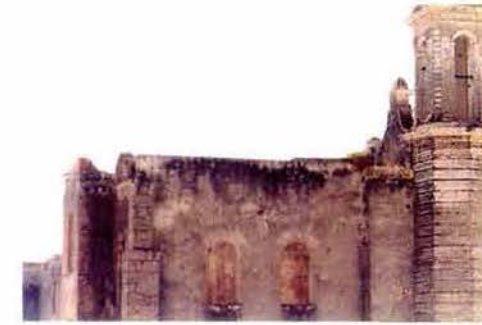
Detalle superior de la fachada
