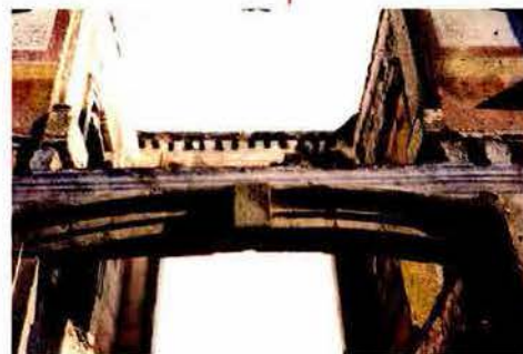
Desde el vestibulo hacia la escalera posterior
