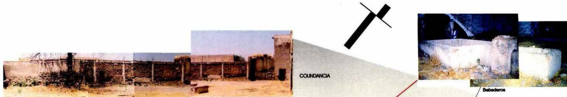
Muro de colindancia posterior
