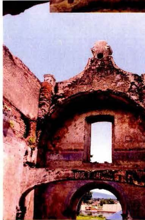
Interior de la capilla hacia el sur
