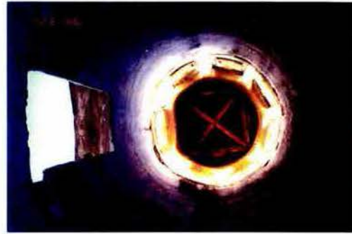
Estructura de la cubierta desde interior
