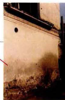
Muro de planta baja
