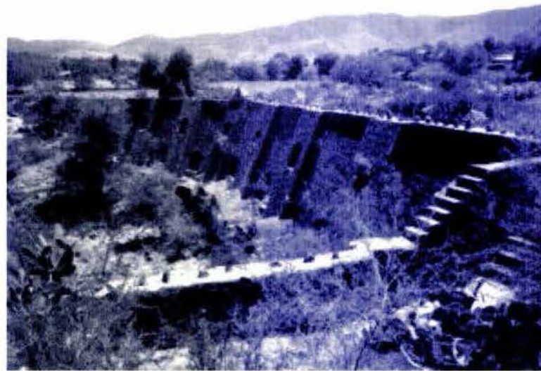
Restos de la presa en la Hacienda los Desmontes
