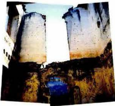
Vista de los muros en el ala poniente
