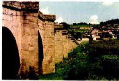
Puente a la entrada del pueblo
