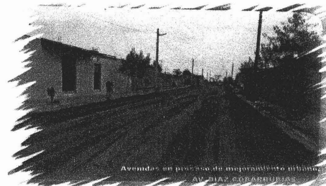
VIAS DE COMUNICACION EN PROCESO DE MEJORAMIENTO AV. ANTONIO DIAZ COBARRUVIAS
