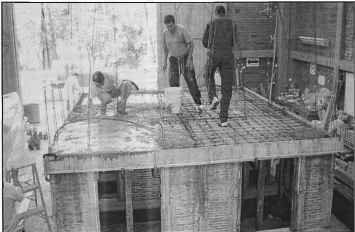
Fig 3.13 - Construcción entrepisos
