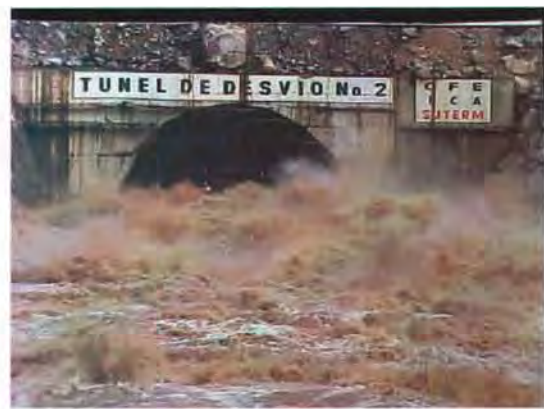
Portal de salida túnel No 2 de Aguamilpa
