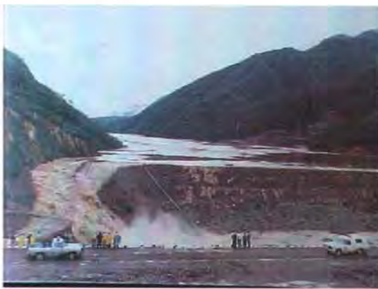
Descarga por el canal fusible
