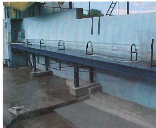
Túnel instalado sobre plataforma
