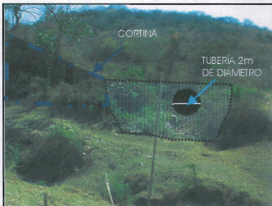
Fig. VI.5 Obra de toma Presa Amilcingo
