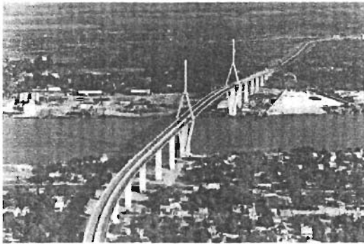
Figura 32. Puente de Caminos y Puentes Federales (CAPUFE)
