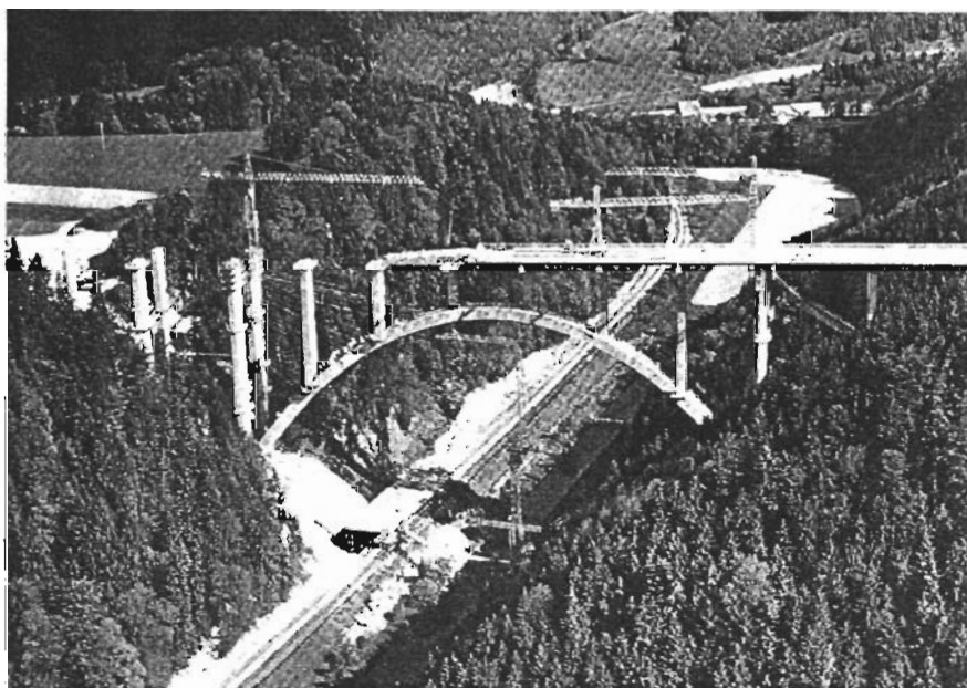
Tramo en voladizo de un puente arqueado.
