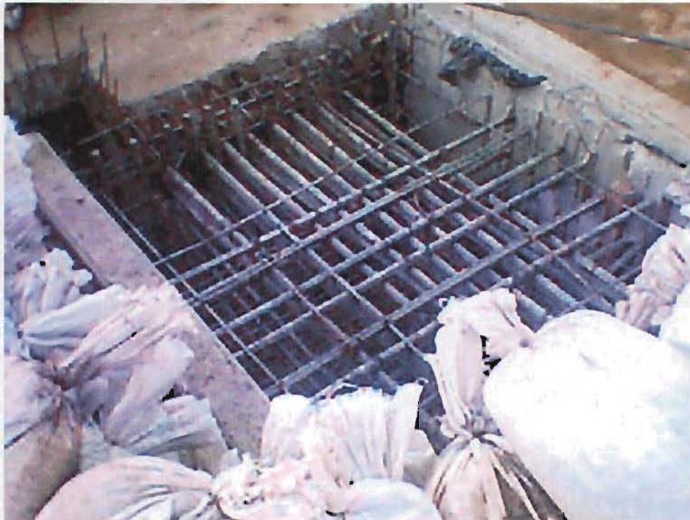
Fig. 3.6.1.- Acero longitudinal y transversal del candelero.
