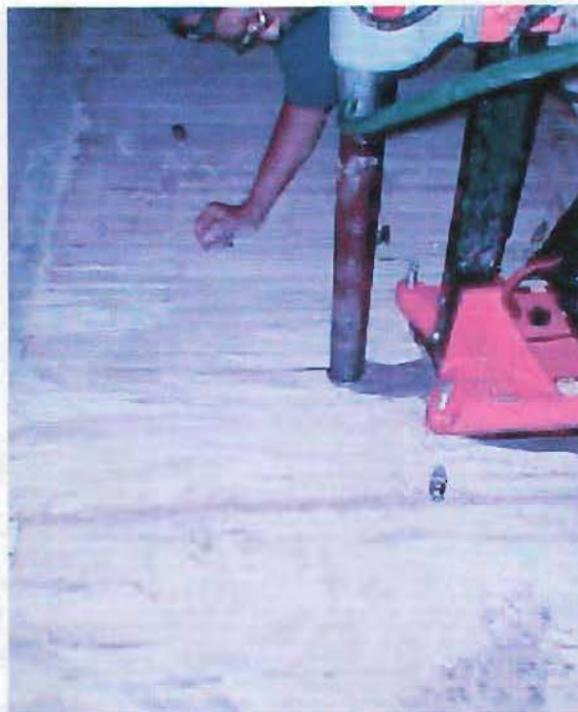
Fig. 4.3.1. Extracción de corazones en concreto
