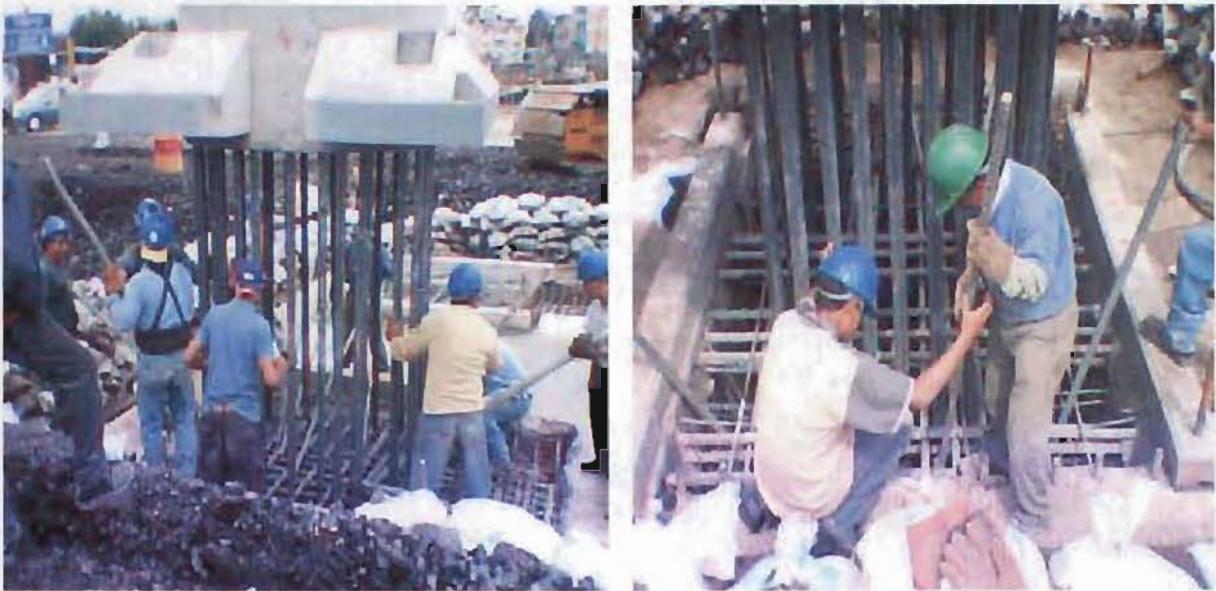
Fig. 3.5.5.- Montaje de la columna, forzando el acero para dicho fin.
