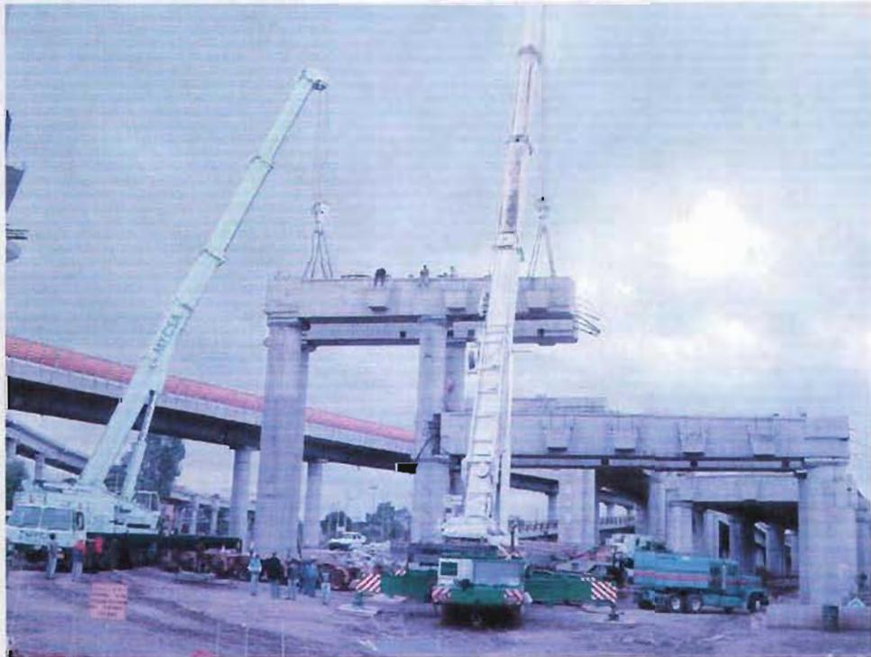
Fig. 3.7.2.- Montaje de cabezal por 2 grúas de 350 tons.
