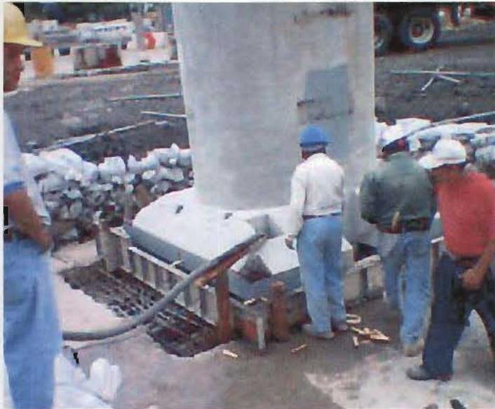
Fig. 3.6.4.- Colocación de concreto dentro del candelero.
