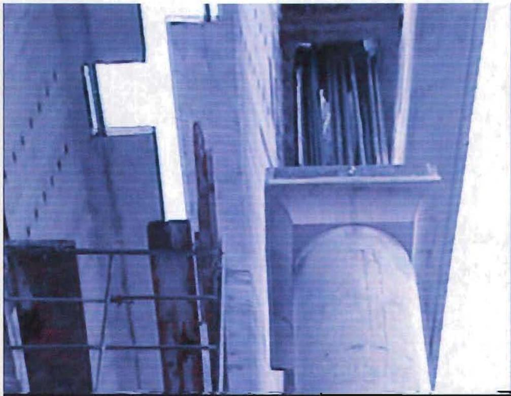
Fig. 4.5.3.- Montaje de cabezal en columna.
