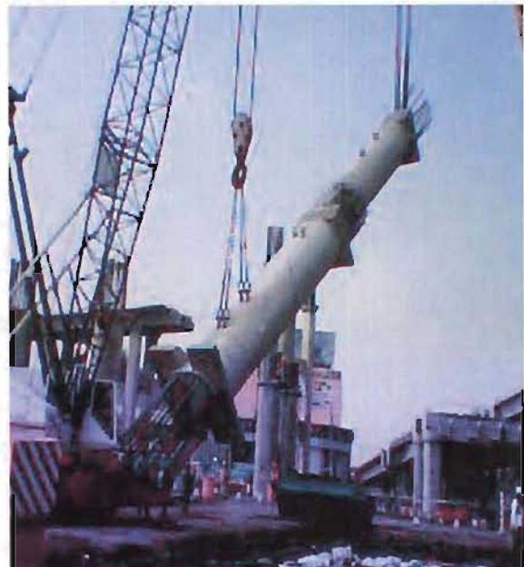
Fig. 3.5.4.- Levantamiento de columnas para su colocación.
