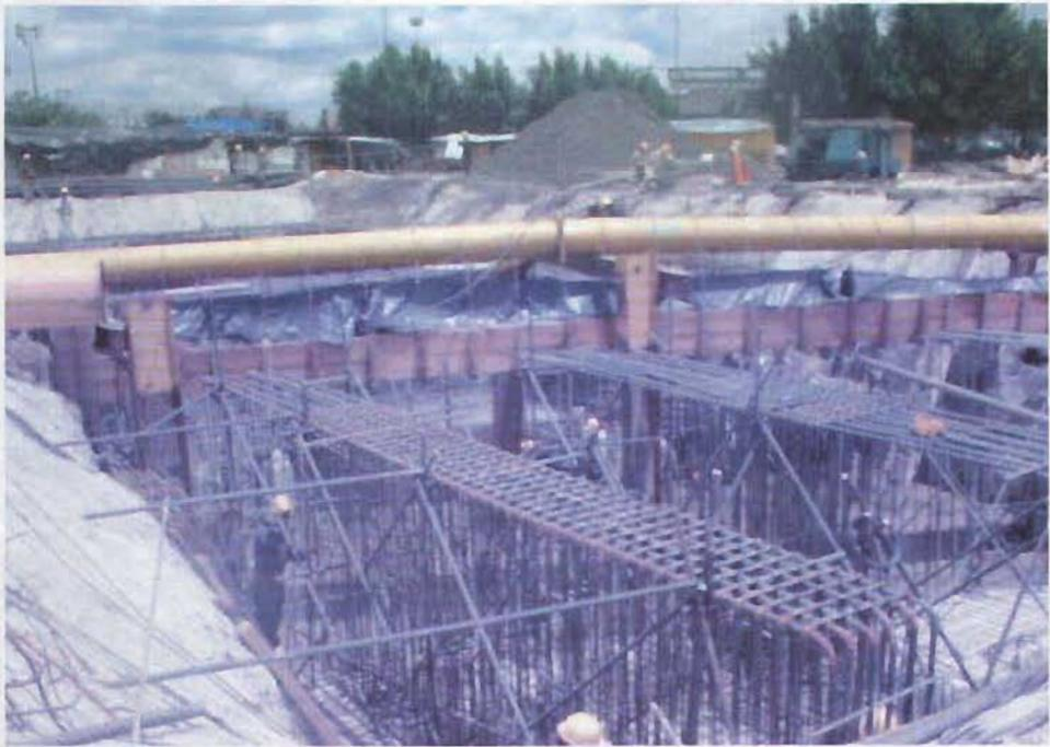
Fig. 3.2.1.- Colocación de acero en cimentación.
