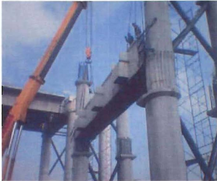
Fig. 2.7.1.- Montaje de cabezal.
