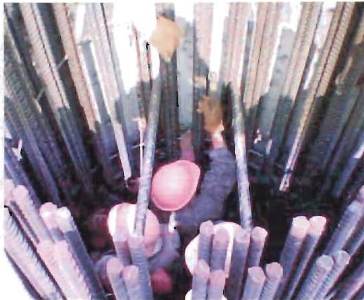
Fig. 2.4.1.- Colocación de acero para columna Tipo I.
