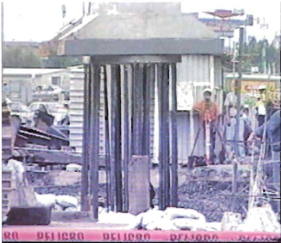
Fig. 2.6.1.- Nivelación de la columna.
