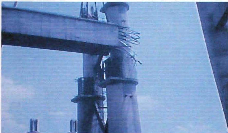
Fig. 4.4.1.- Montaje del Cabezal en la preparación de la columna.
