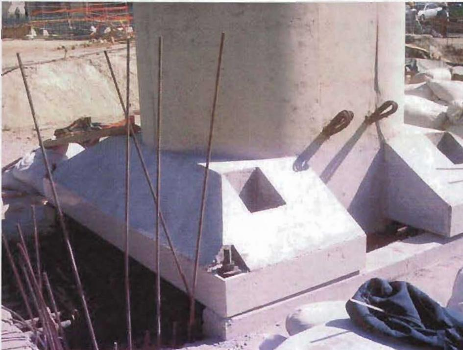
Fig. 3.6.3.- Columna montada y nivelada.
