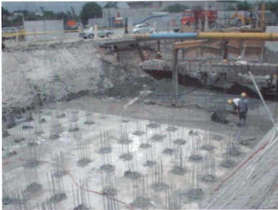
Fig. 2.1.2.- Colocación de la plantilla de concreto.
