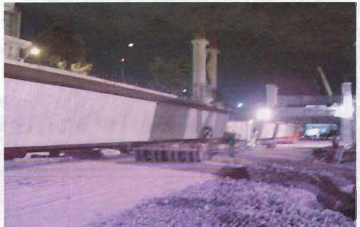
Fig. 3.5.2.- Llegada de elementos prefabricados con ausencia de auxilio y señalamiento vial.
