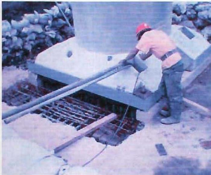
Fig. 4.6.1.- Nivelación de la columna.
