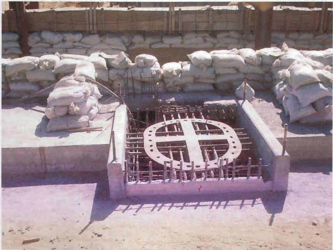
Fig. 3.6.5.- Plantilla metálica.
