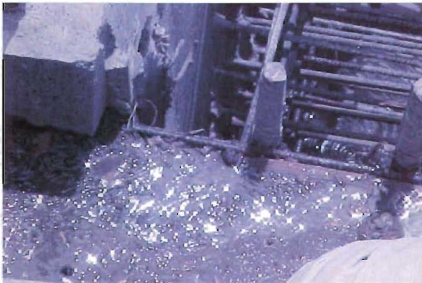
Fig. 2.3.2. Colocación de curacreto en elementos estructurales.
