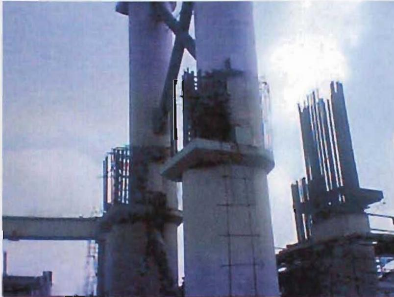
Fig. 3.4.2.- Preparación para recibir al cabezal.
