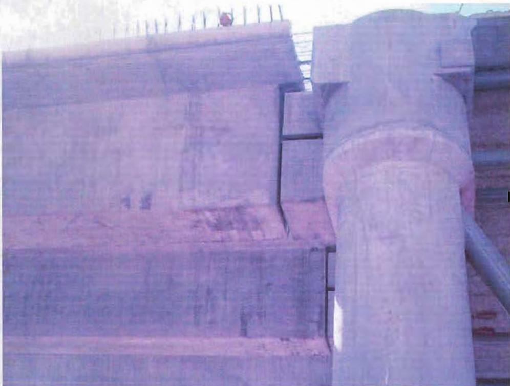
Fig. 3.7.4.- Unión de trabe con cabezal.
