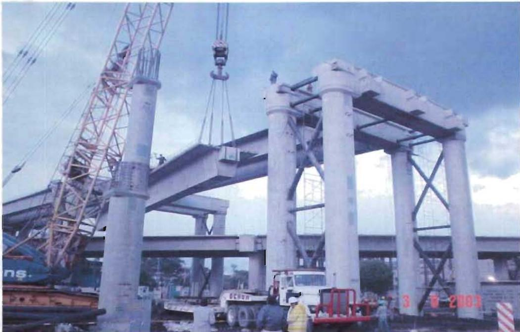
Fig. 2.5.3.- Montaje de Trabe.
