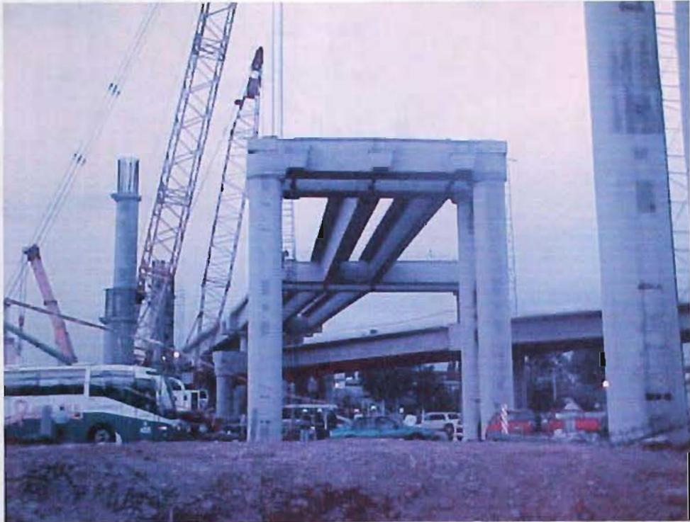
Fig. 3.7.1.- Marco formado por cabezal y columnas.
