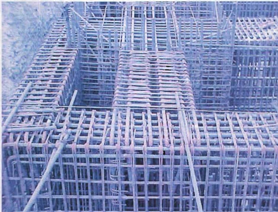
Fig. 4.2.1.- Acero colocado y habilitado para cimentación.
