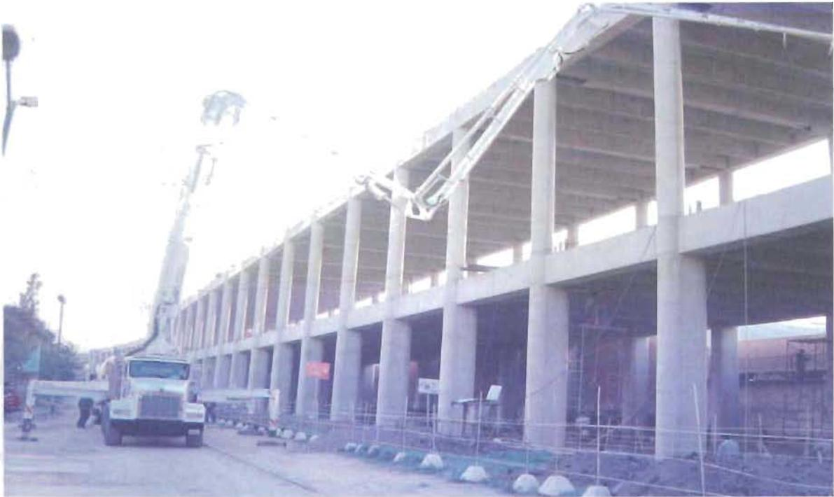
Fig. 2.3.1. Colocación de concreto a través de bombeo
