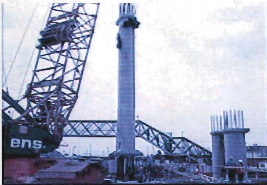
Fig. 4.5.2.- Montaje de columna en candelero.
