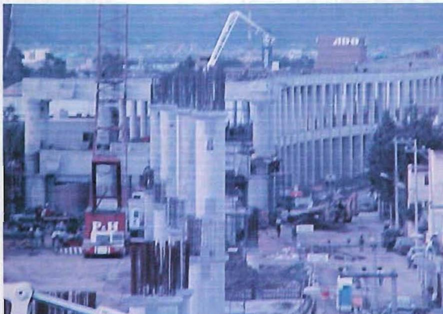
Fig. 4.3.2. Colocación de concreto en el segundo nivel.
