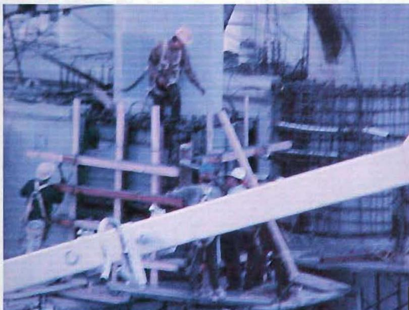
Fig. 4.4.2. Preparación para la colocación del concreto.
