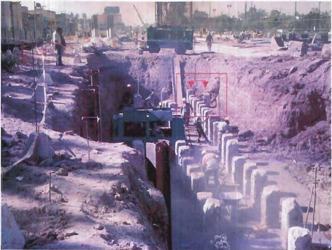
Fig. 3.1.3.- Pilotes desalineados con respecto a proyecto.
