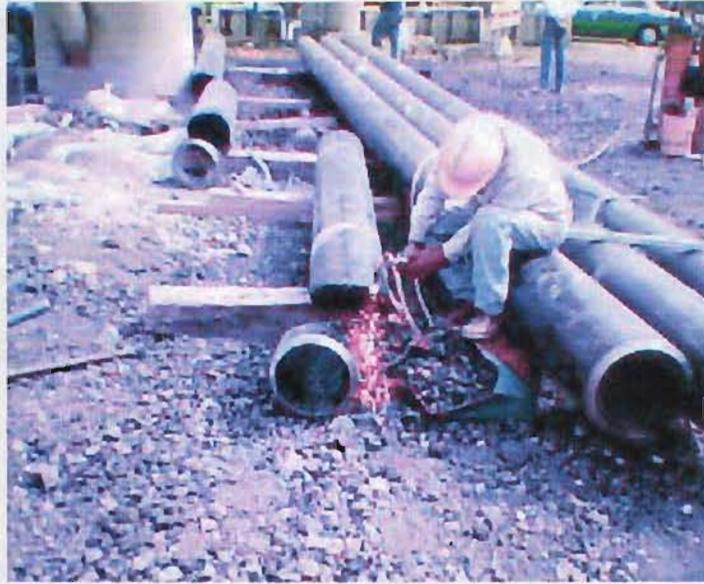
Fig. 4.8.1.- Corte de tubo en campo.
