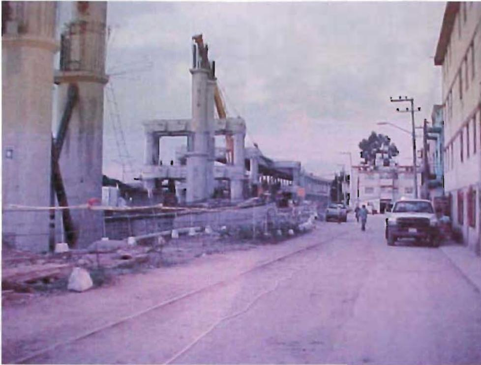
Fig. 2.4.2.- Columnas Tipo I o Mixtas.
