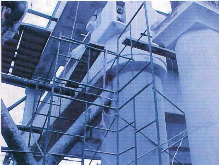
Fig. 4.7.2.- Torones postensados y recortados.
