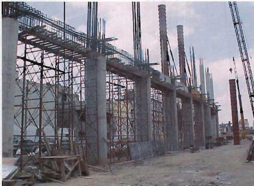
Fig. 3.3.1.- Colocación de cimbra metálica para fabricación de columnas.
