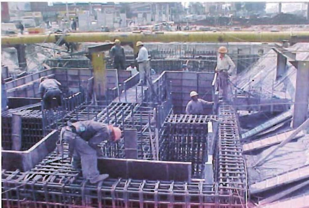
Fig. 2.3.1.- Colocación de acero para cimentación.
