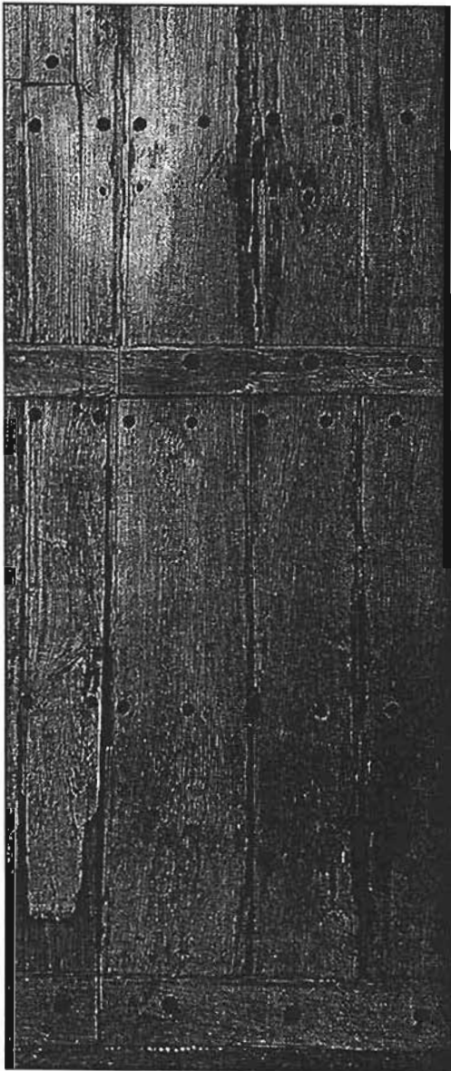
Figura 9 Detalle de puerta
