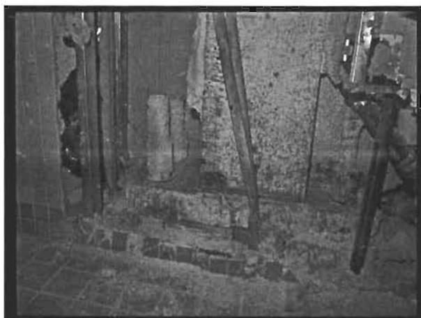
Figura 3.14 Deformación de anclas del lado opuesto del arriostramiento
