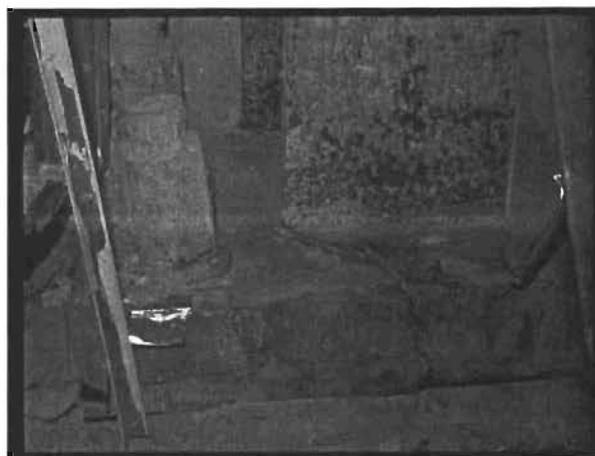
Figura 3.15 Fractura de la placa base y deformación de anclas
