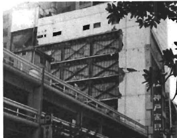
**Figura 3.23** Pandeo de arriostramiento en edificio tipo lápiz
