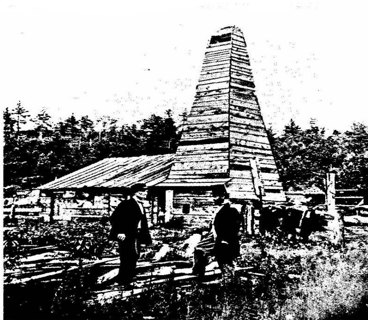
Figura 5. Casa de máquinas 4 .
