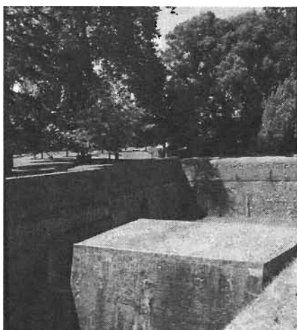
Cortadura en el foso de la muralla de Luca, Italia.
