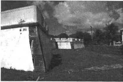
Fachada posterior del Forte de las Cinco Puntas. Recife, Brasil.
