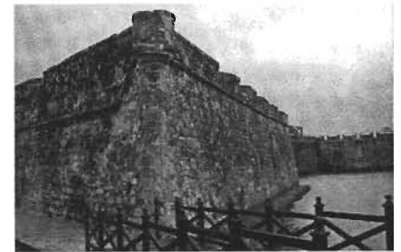
Cara del Baluarte de Veracruz, San Juan de Ulúa, Rematada por las cañoneras y los merlones.
