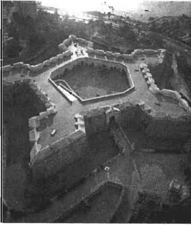
San Diego de Acapulco fue la única obra defensiva en México con traza pentagonal.
