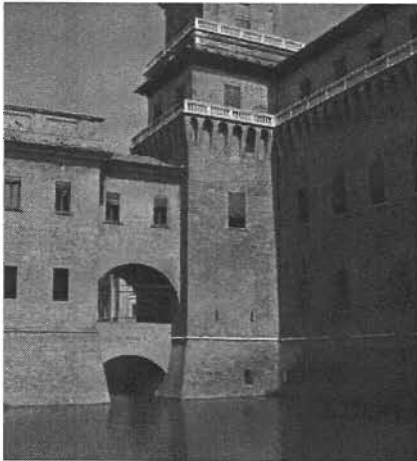
Torres, ventanas y arcos medievales del Castillo Estense de Ferrara, Italia
