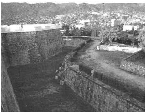
Muralla, foso y camino a cubierto. San Diego, Acapulco.
