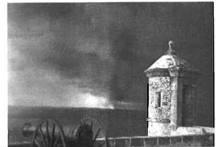
Puente levadizo y Frente de mar del reducto de San Miguel, Ccmpeche. El parapeto daba mayor movilidad a los cañones.
