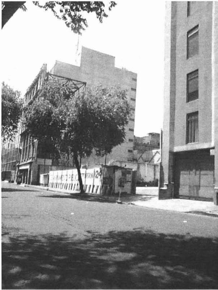
Fotografía 7 Vista del Acceso del Terreno
