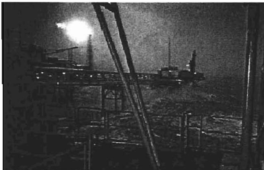
A Ver Figura 5.12 Imagen del complejo de producción abkatum-a, de Pemex Exploración y Producción, durante el paso del huracán Roxanne. Octubre 1995.
