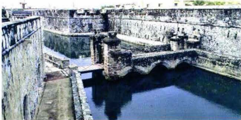
Figura 10. Vista de los muros que rodean a el Fuerte de San Juan de Ulúa.
