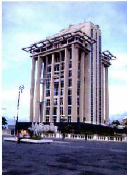
Figura 1. Torre de Pemex.
