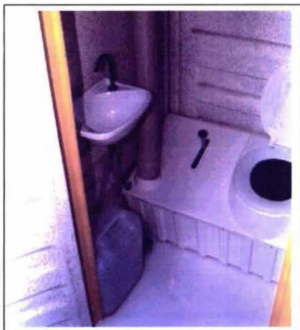
Figura 80. Muestra del interior de los baños.
