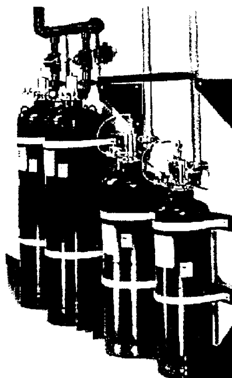
Fig. III.8 Tanques de Almacenamiento. (19)
