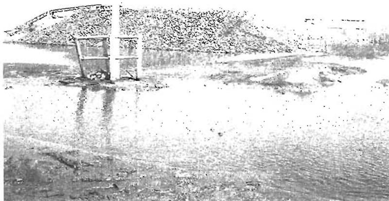
**Foto 9** Vista de un depósito de arrabio y encharcamientos de la plataforma que revela las deformaciones en la superficie de la misma.
