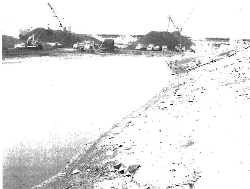
**Foto 10** Detalle del hundimiento excesivo derivado de la falla del suelo. En la parte derecha se observa el talud del la capa de suelo cemento que se vio involucrado en el levantamiento del terreno en la zona de la espuela..
