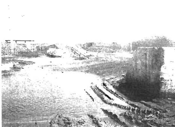
**Foto 6** Deformaciones de la plataforma de Almacenamiento. Al fondo se observa la espuela deformada y daños a la capa de suelo cemento.
