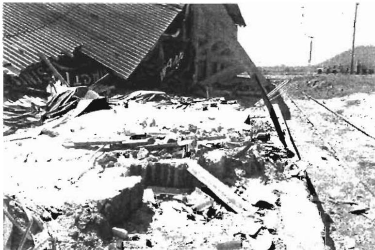
Lo anterior indujo sobreesfuerzos mecánicos, primeramente a manera de flexión sobre el plano del muro en la sección indicada y en segundo término la falla frágil por esfuerzo cortante, lo que conllevó a la totalidad de la superestructura a un estado límite de falla, se muestra fotografía donde se aprecia las condiciones en las que quedó la bodega.
