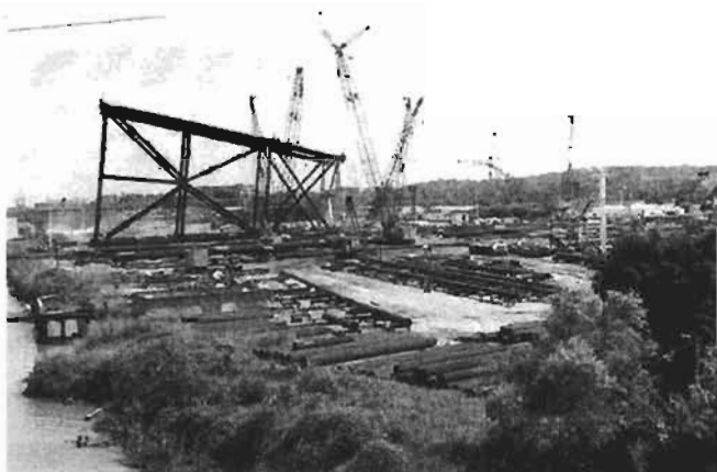
"Vista general del Astillero"
