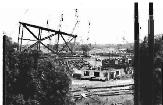
"Vista general del Astillero"
