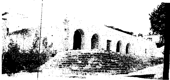
Fig.63. Vista de la fachada sur de la cárcel
