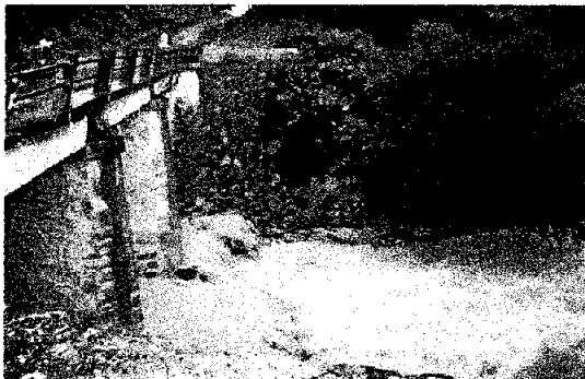
Fig.39. Vista de un puente y río contaminado por la descarga de aguas negras
