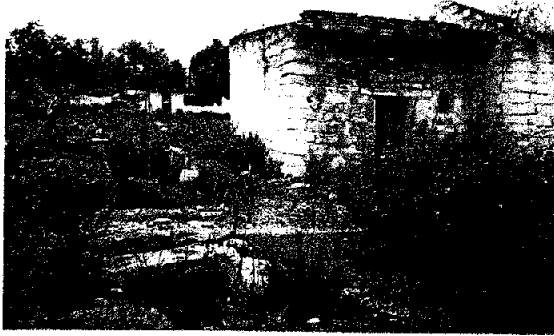
Fig.32. En la parte inferior izquierda, hoyo donde se tejía la palma. Tiene un área aproximada de 1.50 x 2.00 x1.20
