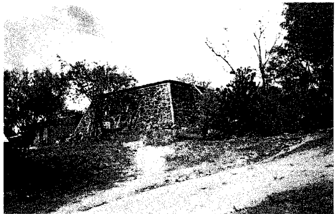
Fig.27. Imagen de un tanque de distribución de agua potable en la actualidad.
