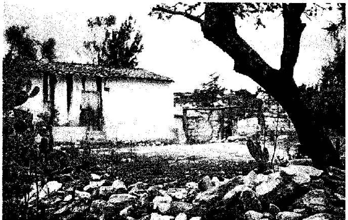
Fig. 16 El deterioro que se observa en esta fachada, es solo un ejemplo de lo que se puede observar en muchas de las viviendas de Coixtlahuaca
