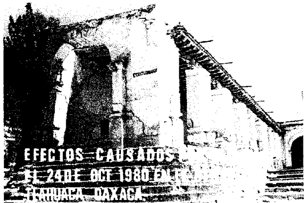
Fig.48. Vista del acceso original hacia la cárcel antigua.
