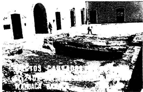
Fig.46. Vista desde la cárcel antigua hacia los edificios consistoriales y la presidencia, se aprecia el deterioro que sufrió por los temblores la techumbre de la cárcel antigua.
