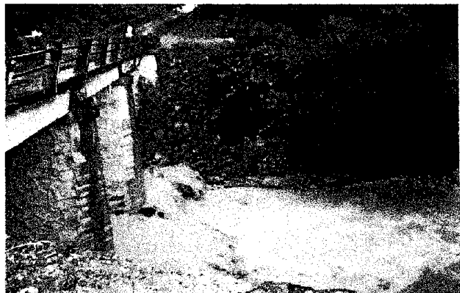
Fig.28. Vista del Río Culebra en el cual desembocan las aguas negras, provocando con esto la contaminación de dicho río
