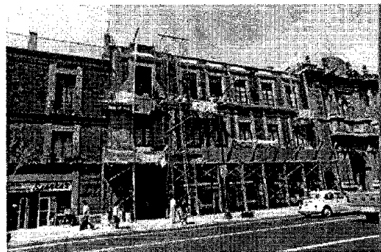
En la imagen, trabajos de remodelación en la calle de Balderas.
