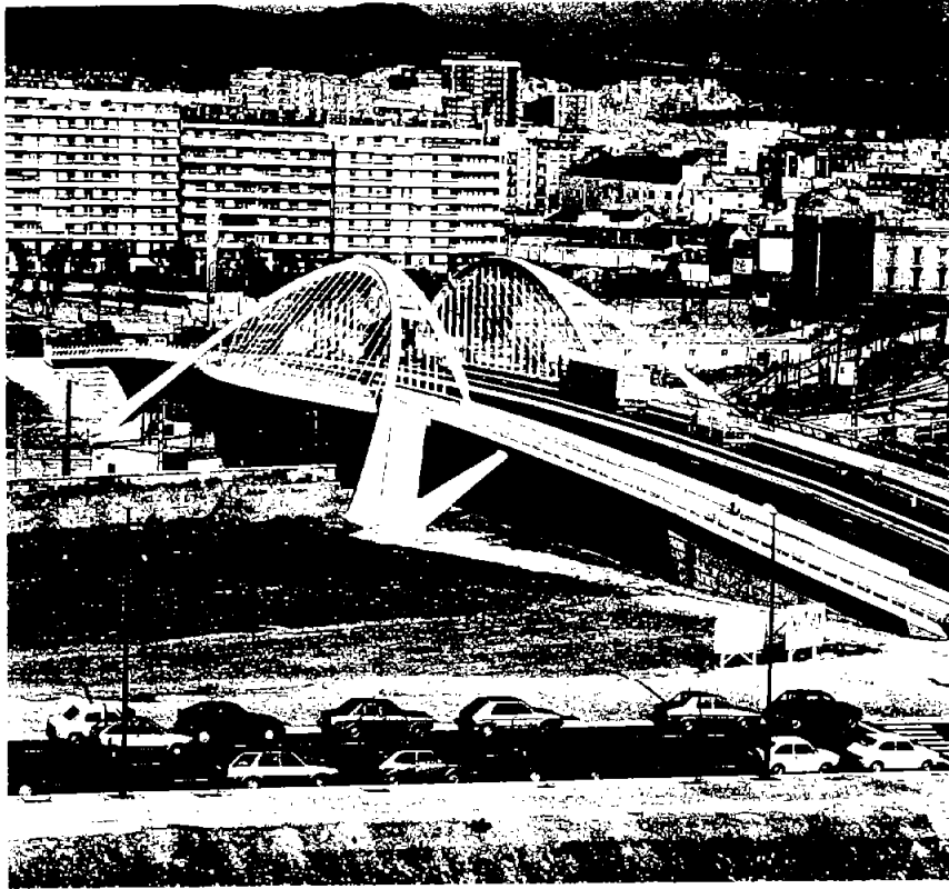
Santiago Calatrava, Puente de Bach de Roda Barcelona, España 1987 32
