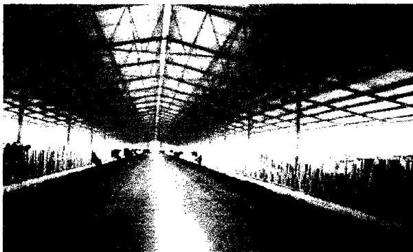
Figura 19. Instalaciones. Cuenca Lagunera, Torreón, Coahuila, Méx.
