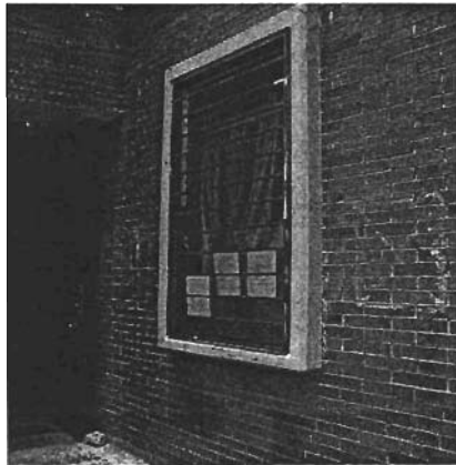
Figura 4.10.- Ventanales con protección que se pueden utilizar como salida alterna.
