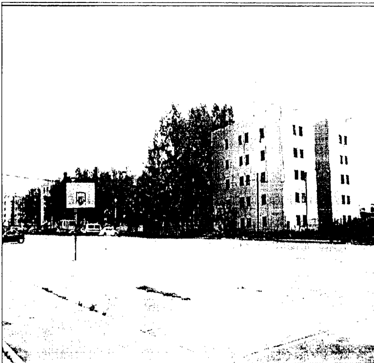
Fig. 1.1 Hundimiento diferencial en una unidad habitacional en Tultitlan, Mex.
