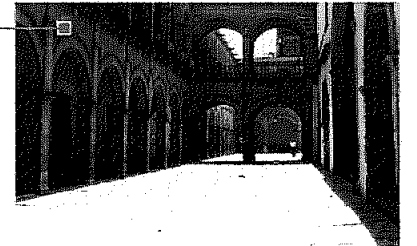
PATIO DE LOS DEPTO. DE BAÑOS
