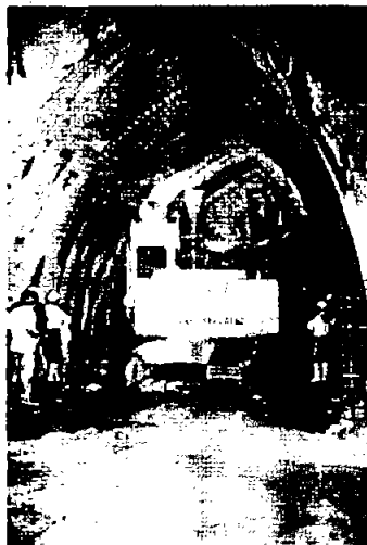
Figura 46. Revestimiento de concreto.
