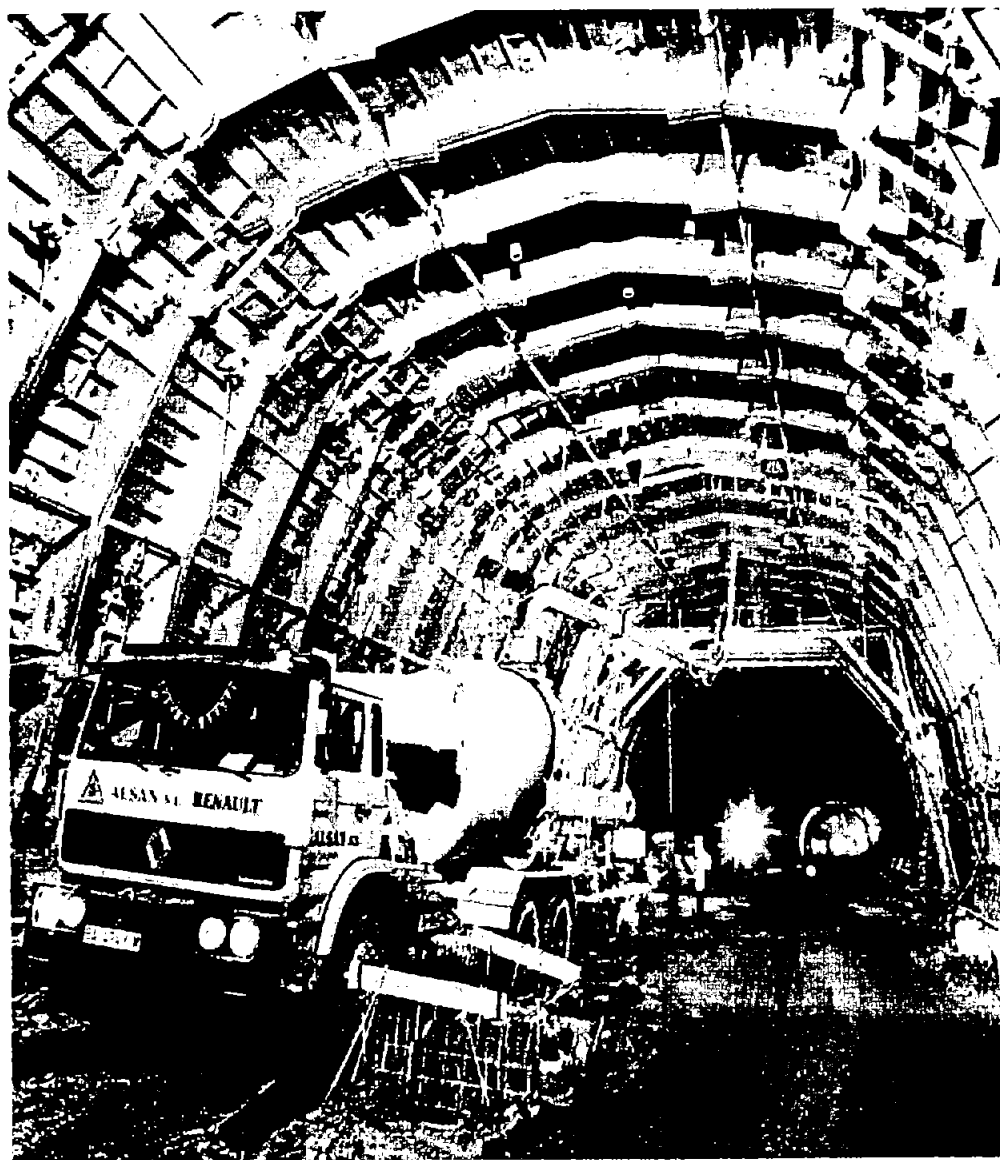
Figura 51. Revestimiento con prefabricados.
