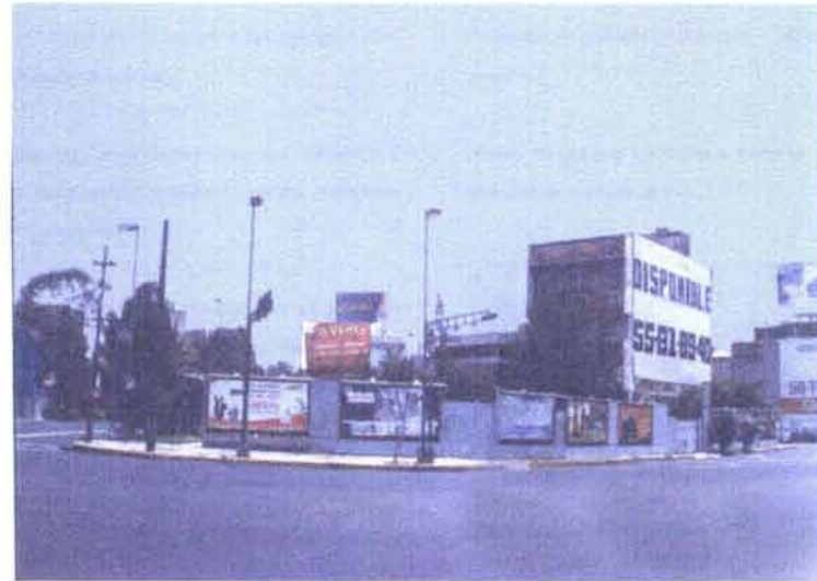
Vista del terreno desde la Av. Insurgentes
