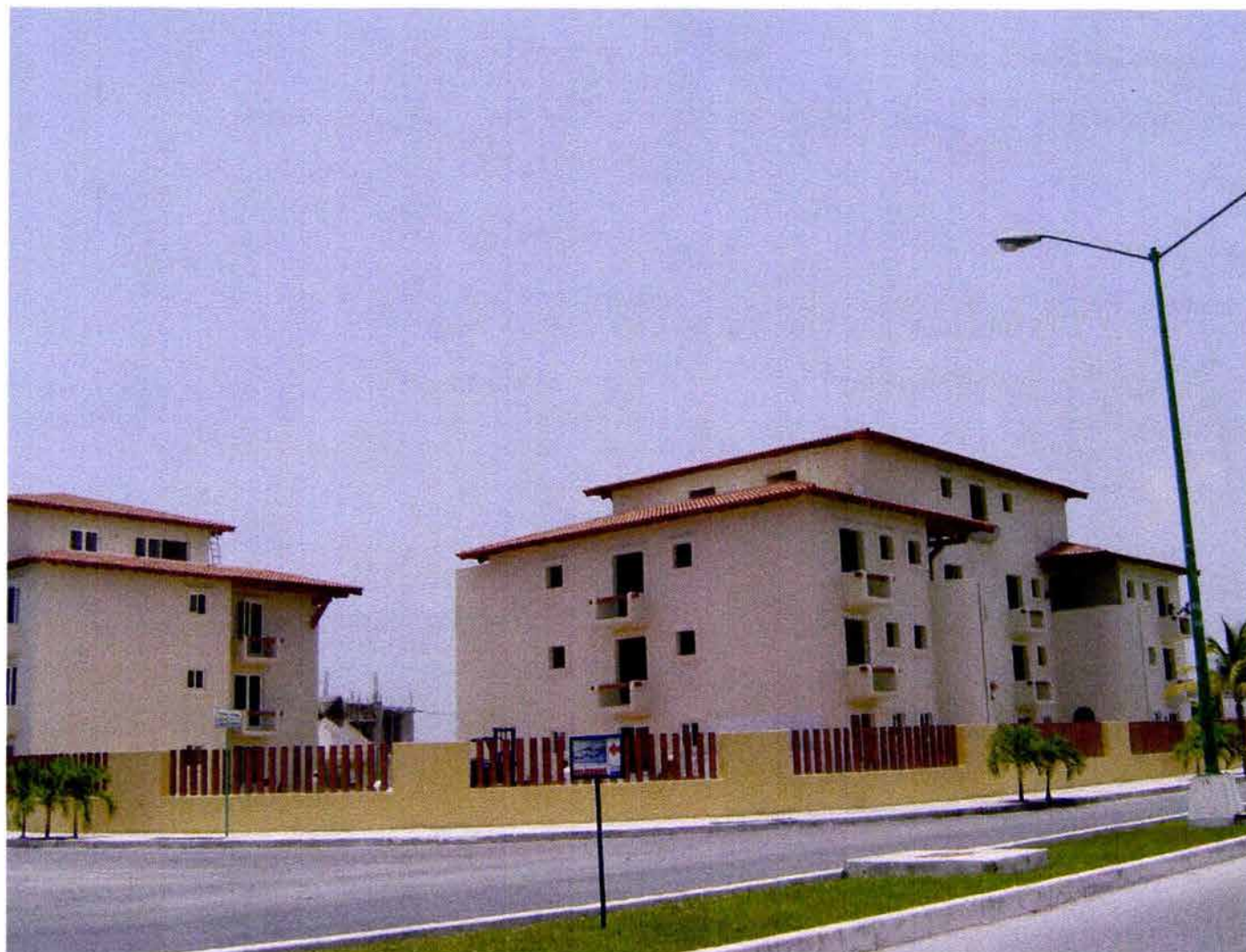
CONJUNTO HABITACIONAL ISLA CAÑADA
