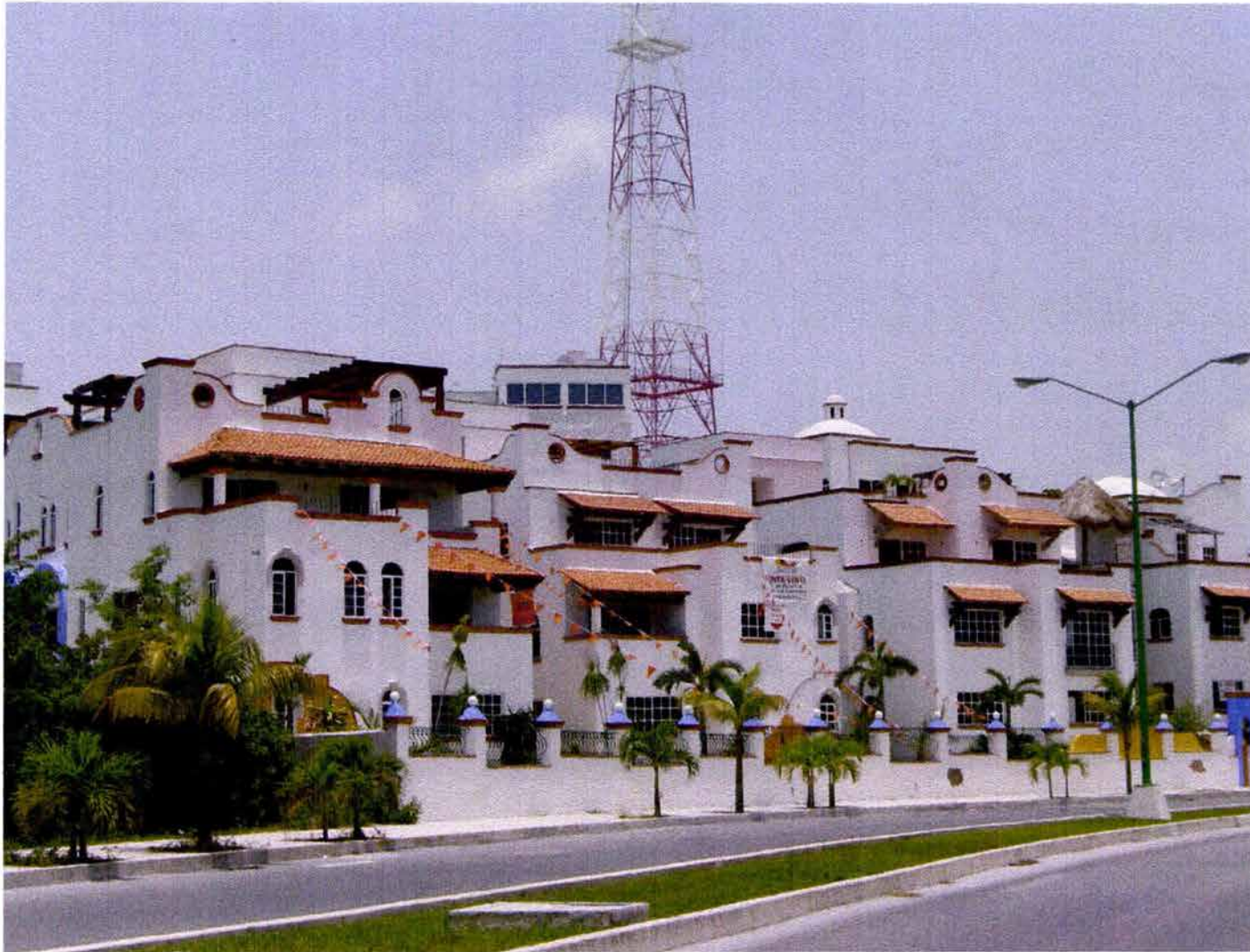
CONJUNTO HABITACIONAL ISLA CAÑADA
