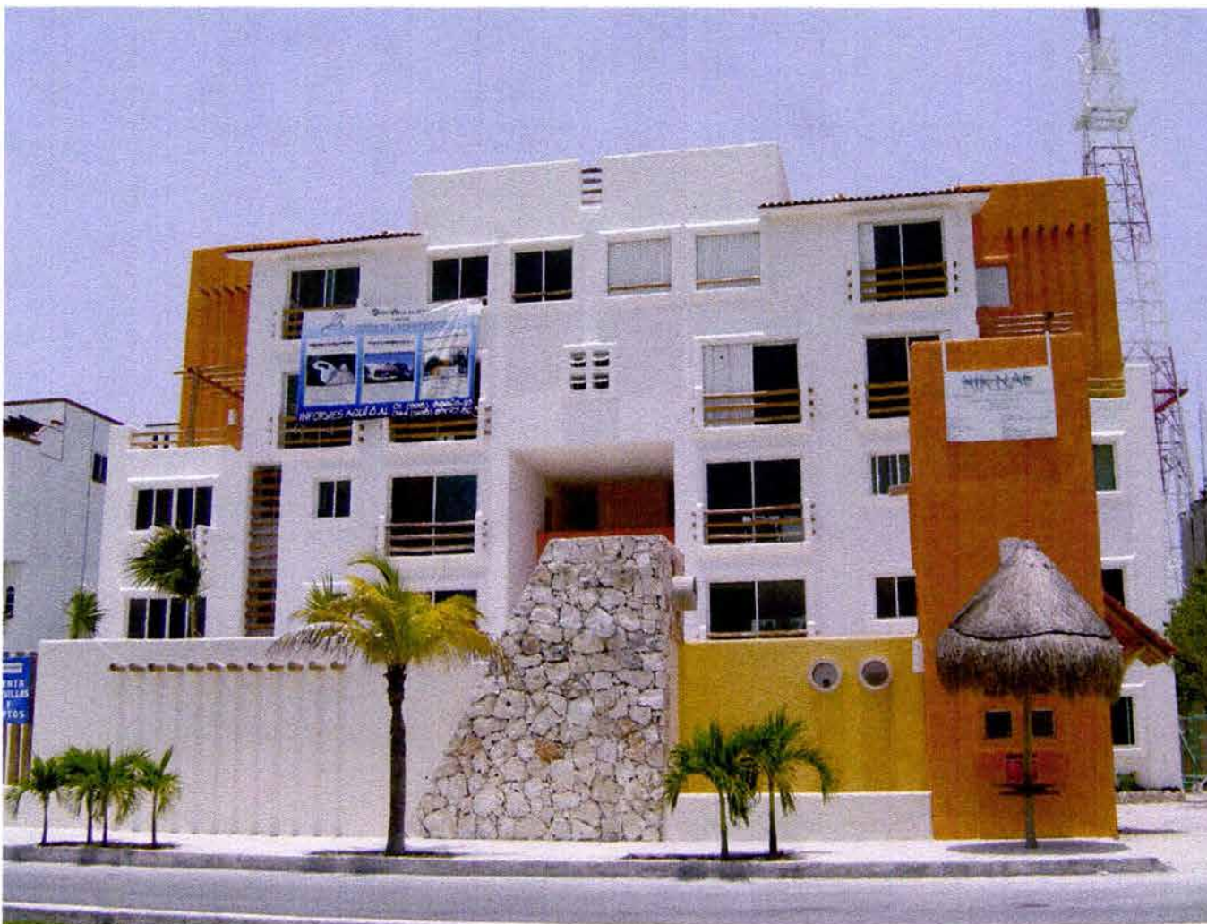
CONJUNTO HABITACIONAL ISLA CAÑADA
