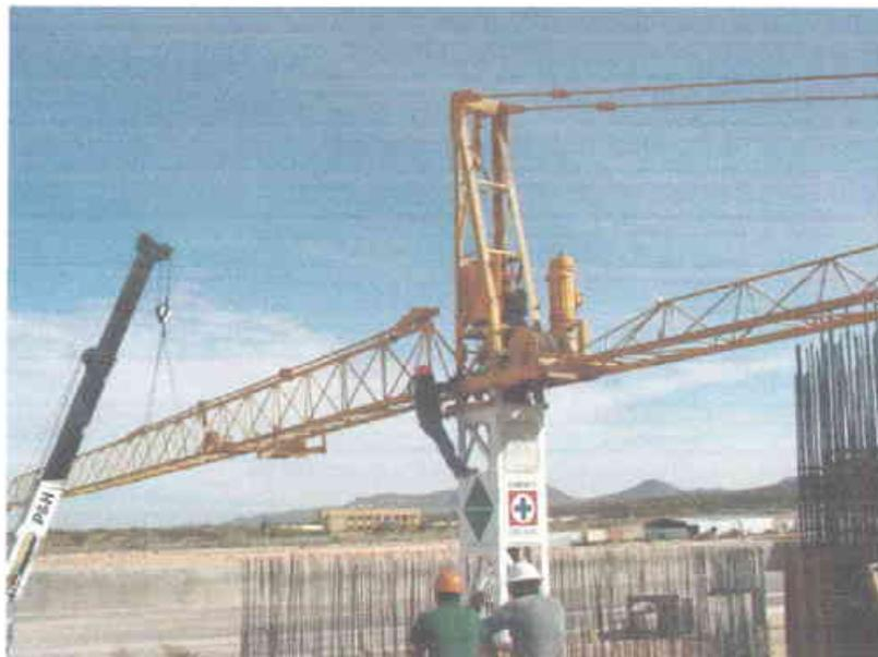
**Figura 3.11 Ensamblaje de torre grúa para trabajos del deslizado en el silo de homogeneización.**
