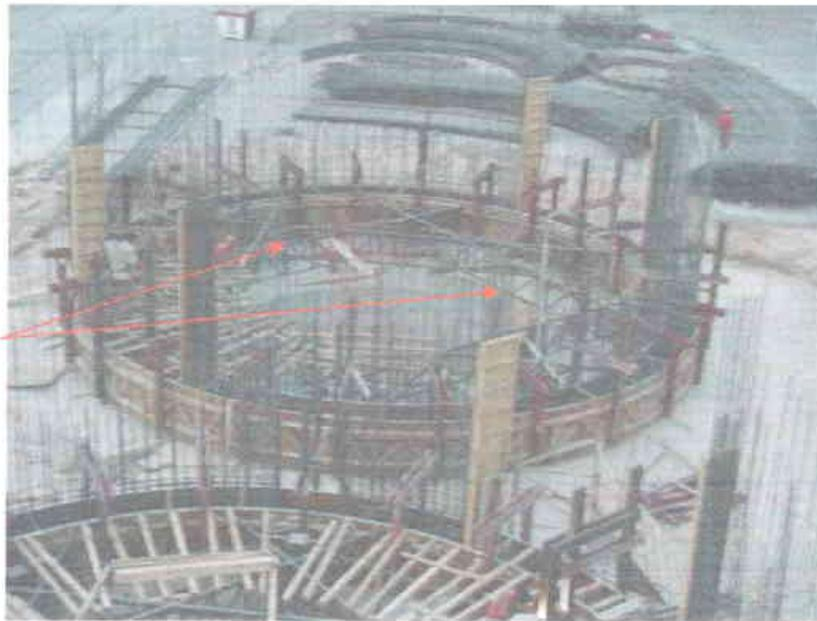
**Figura 4.11 Armado cabrillas y colocación de piernas, silos de cemento 3 y 4.**
