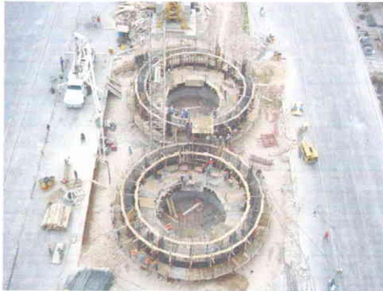
**Figura 4.14 Plataformas de trabajo silos de cemento.**
