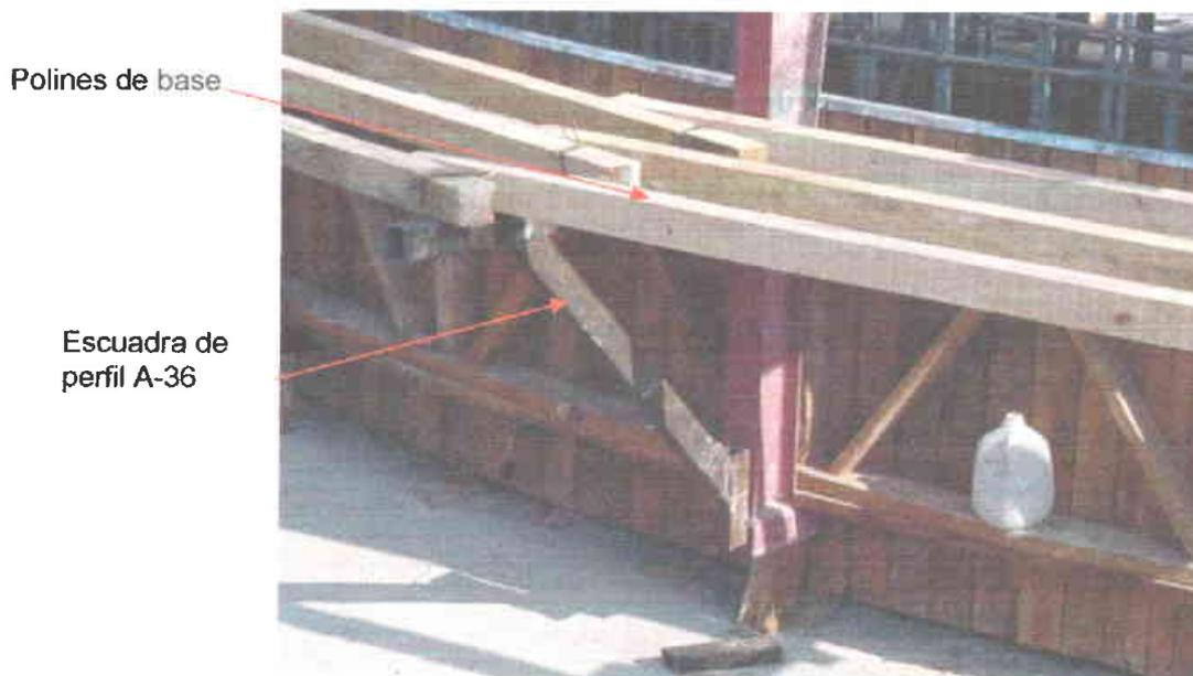
**Figura 2.11 Plataforma de trabajo exterior.**
