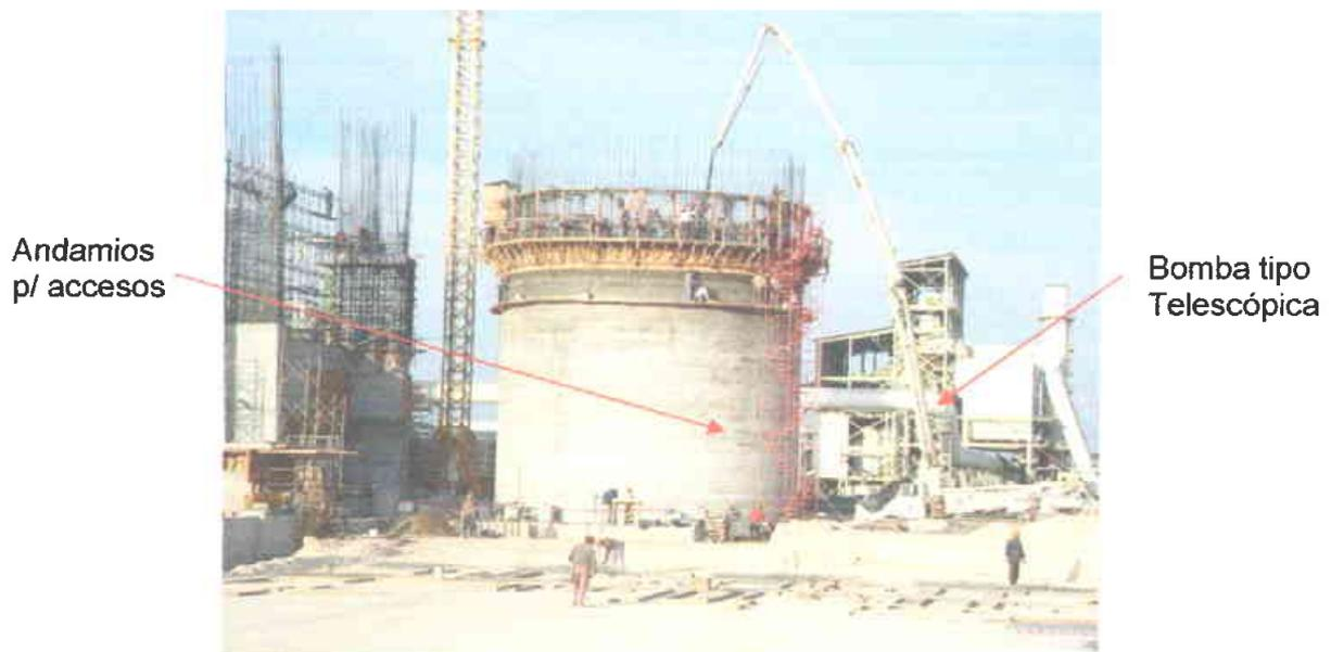
**Figura 3.12 Bomba de concreto tipo pluma y sistema de andamios para accesos.**
