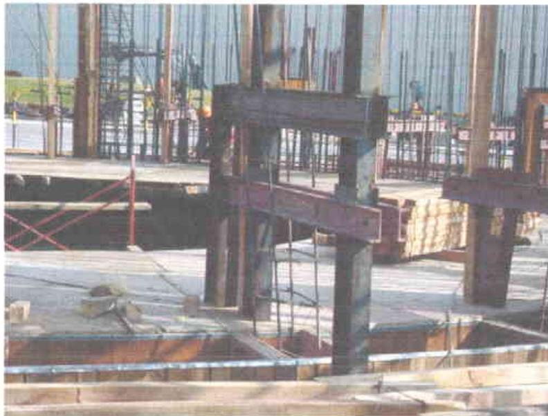
**Figura 4.13 Conformación de piernas y yugos para gatos de 6 ton.**
