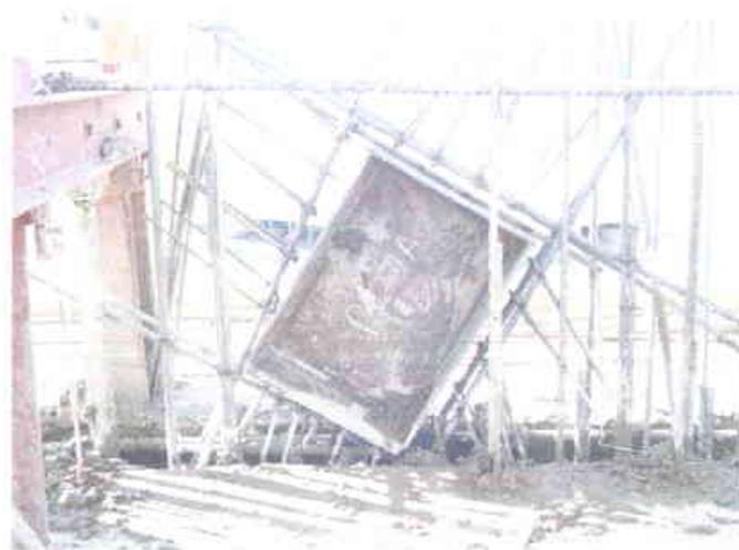
**Figura 3.13 Detalle de colocación de placa y refuerzo adicional de acero.**
