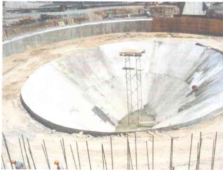
**Figura 5.3 Cono y relleno a nivel de zapata del silo de clinker.**
