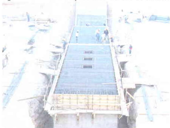
**Figura 5.2 Armado y cimbra en túnel del silo de clinker.**
