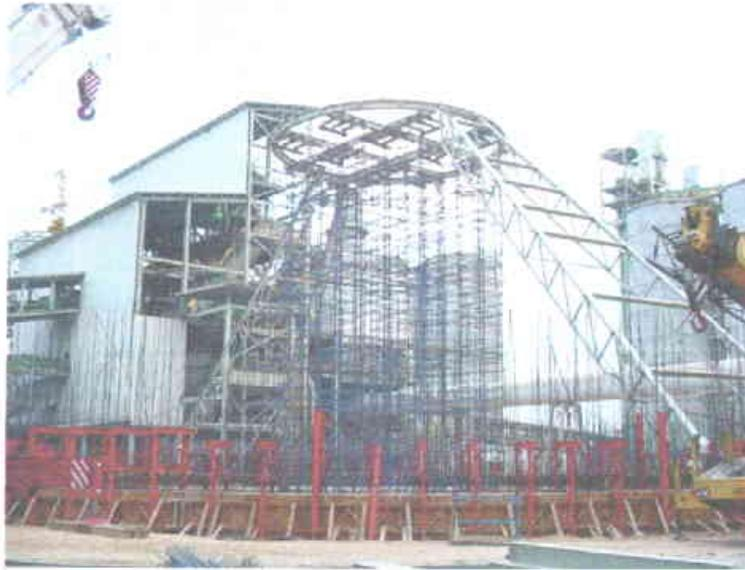
**Figura 5.22 Colocación de armaduras de soporte silo de clinker.**
