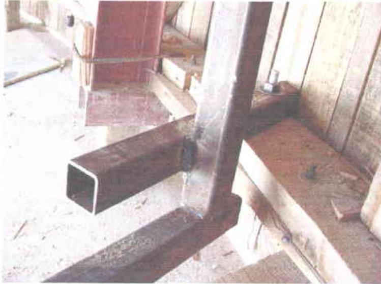
***Figura 2.8 Detalle de unión entre cabrillas y el molde.***
