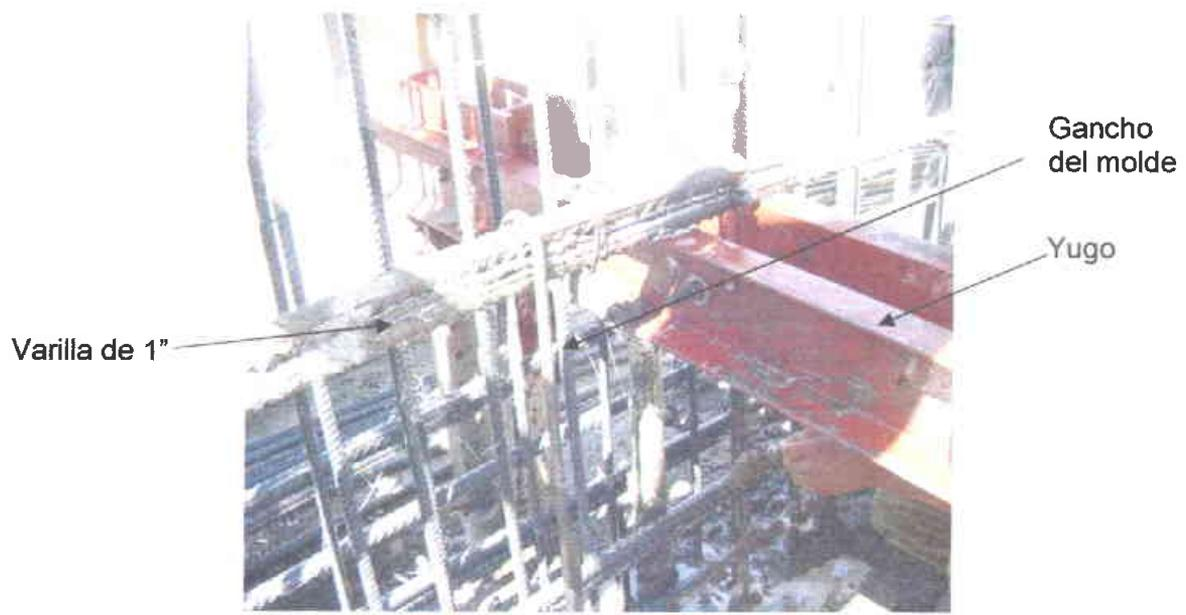
**Figura 3.15 Esquema del sistema de soporte para el nuevo molde.**
