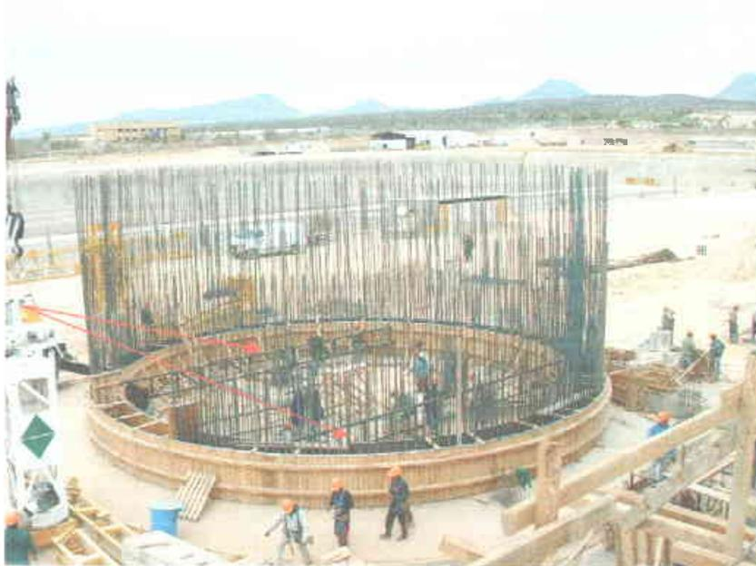
**Figura 3.8 Armado de cabrillas y apuntalamiento de molde.**
