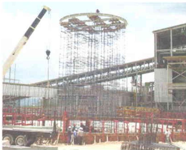
**Figura 5.22 Colocación aro central silo de clinker.**
