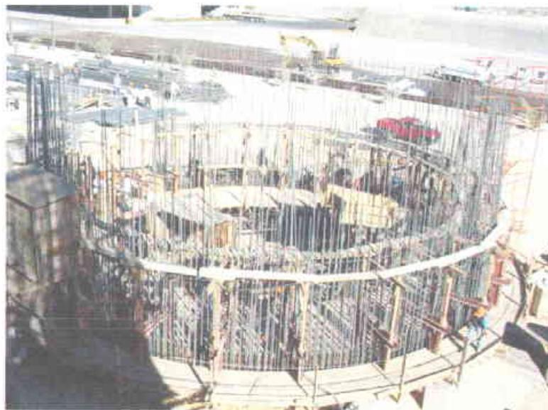
**Figura 3.9 Plataformas de trabajo del silo de homogeneización.**
