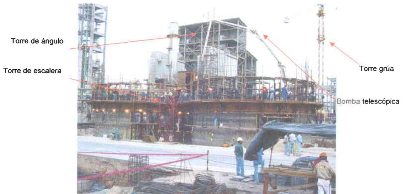
**Figura 4.16 Elementos auxiliares silos de cemento.**
