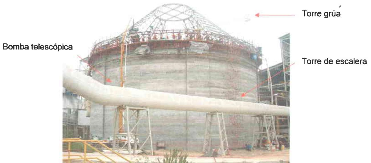
**Figura 5.26 elementos auxiliares silo de clinker.**
