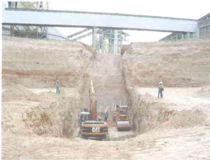
**Figura 5.1 Excavación para túnel del silo de clinker.**
