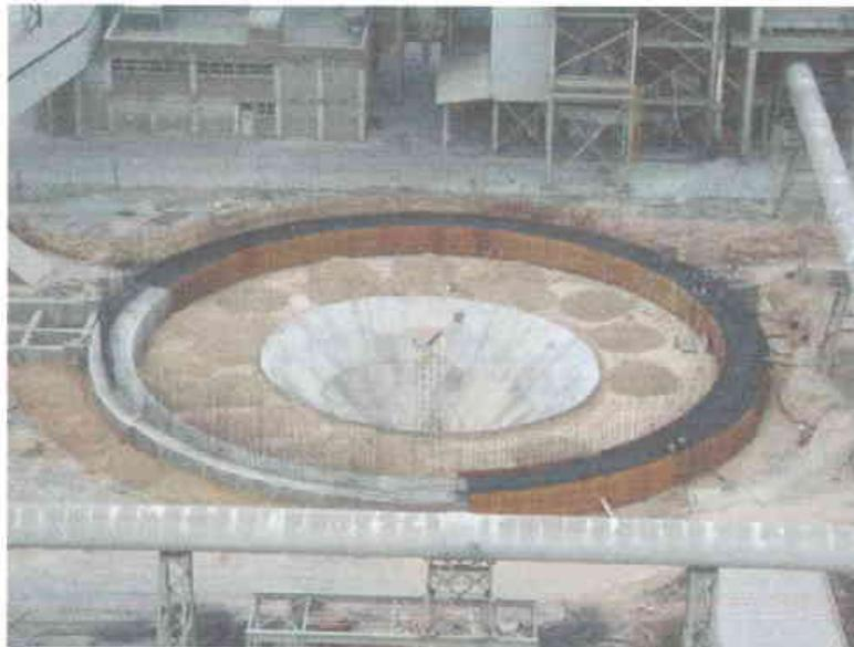
**Figura 5.4 Zapata de cimentación del silo de clinker.**
