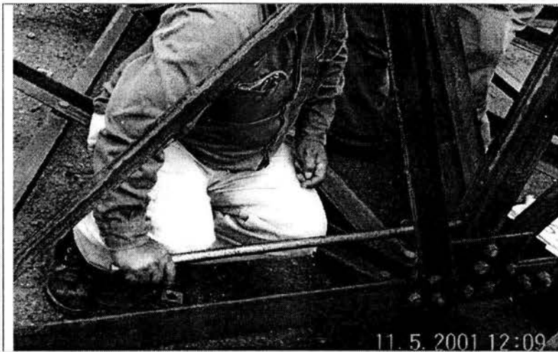
Fig.25 Proceso de apriete de los tornillos.
