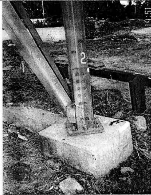
Fig. 15 Detalle de una conexión de placa base.
