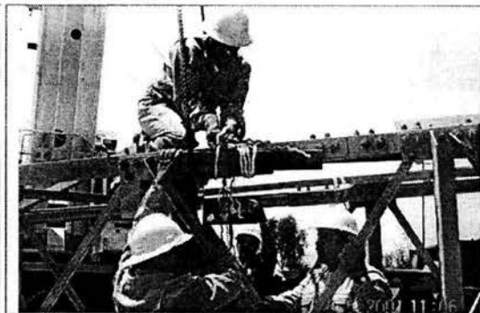
Fig.2 Realizando las preparaciones para el levantamiento de la columna.
