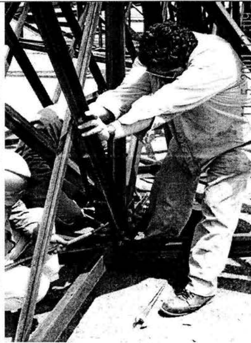
Fig. 17 Ensamblado de la estructura en taller.
