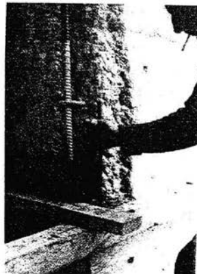
Figura 1.25 Vibración del Mortero.
