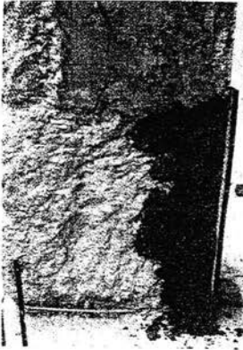
Figura 1.22 Colocación del Mortero.
