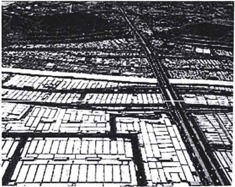
Instalaciones para peregrinos La Meca
