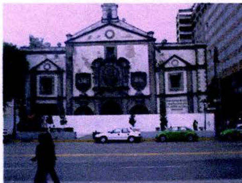
Edificio deteriorado de propiedad federal Av. Juárez (entre Luis Moya y José Ma. Marroquí)
