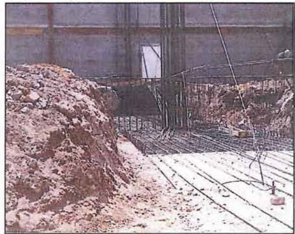
Figura 6.3. Traza parabólica del tendón de preesfuerzo de las contratraves de cimentación.
