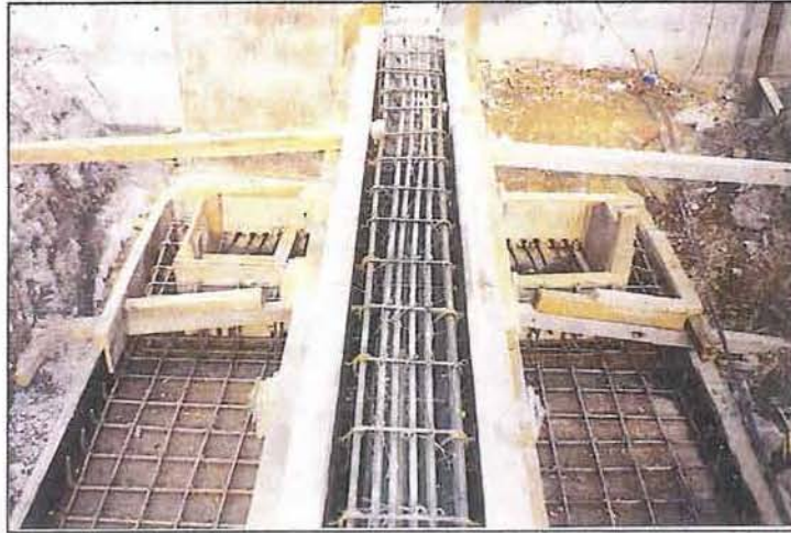
Figura 6.5. Preparación en las zapatas para el tensado de los torones traslapados del tendón de preesfuerzo de las contratraves de cimentación, cerca al eje B del edificio.
