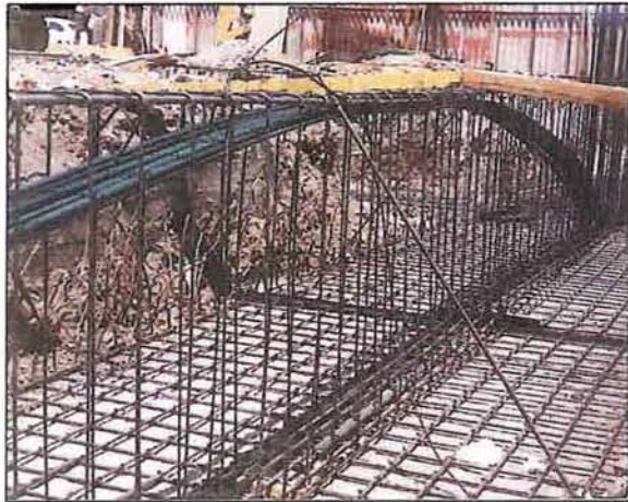
Figura 6.3. Traza parabólica del tendón de preesfuerzo de las contratraves de cimentación.
