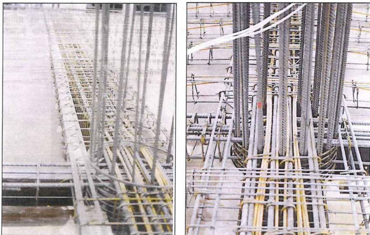
Figura 6.11. Colocación de torones de preesfuerzo para el tensado de las trabes de la estructura.
