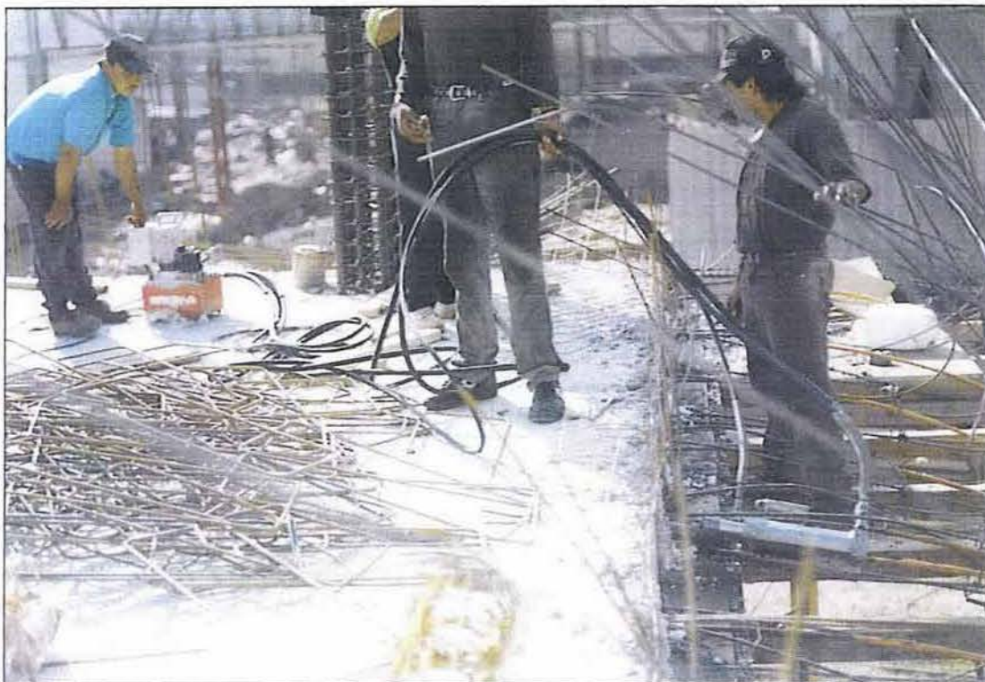
Figura 6.15. Equipo y personal para realizar las operaciones de tensado de los torones de preesfuerzo en las nervaduras de las losas después de un colado.
