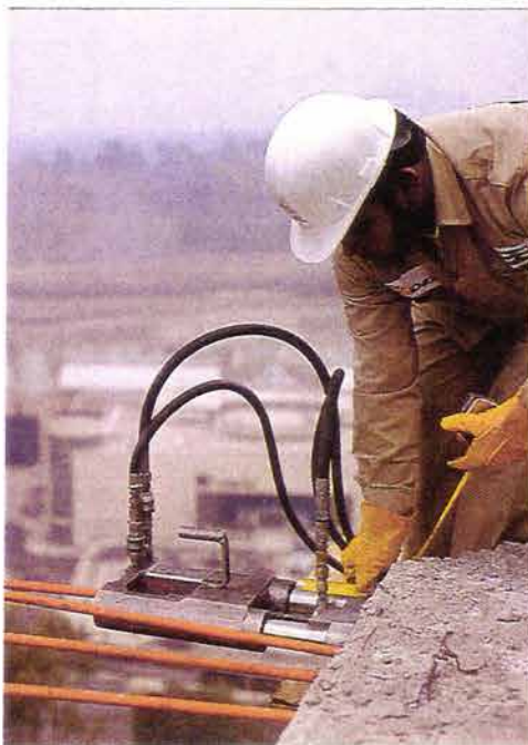
FIG. 2.34. OPERACIONES DE TENSADO [MEDICION DE ALARGAMIENTOS]
