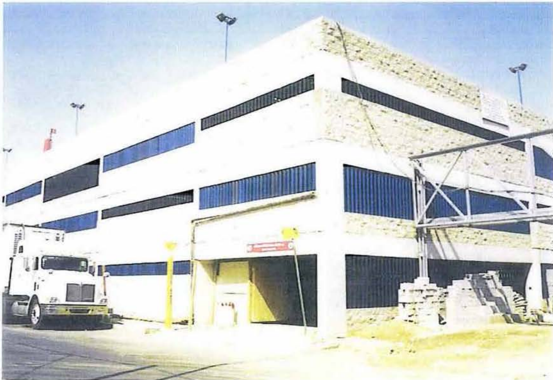
Figura 6.26. Estructura en las fachadas exteriores en los últimos trabajos para terminación de la obra.
