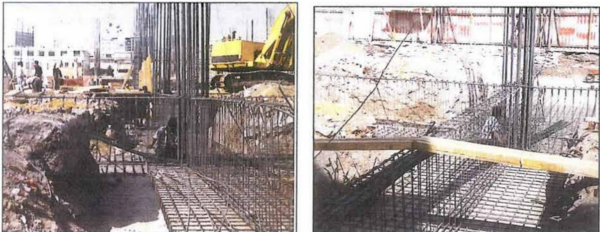
Figura 6.2. Colocación de los torones para preesfuerzo de las contratrabes de cimentación.
