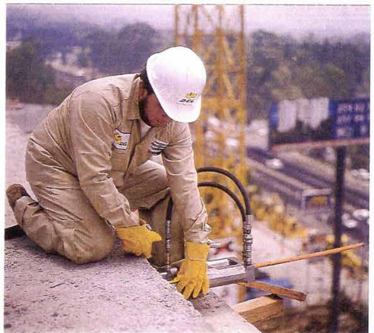
FIG. 2.34. OPERACIONES DE TENSADO [MEDICION DE ALARGAMIENTOS]
