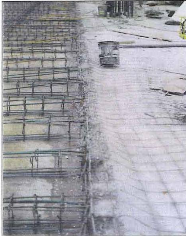
Figura 6.14. Aspecto de las losas después de un colado parcial. Zona de anclajes vivos para preesfuerzo de las nervaduras.
