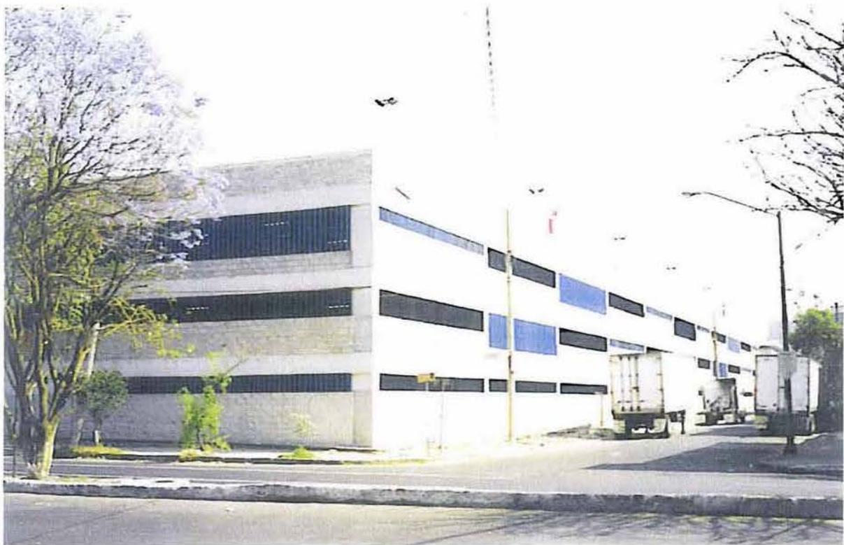
Figura 6.27. Aspecto final de el edificio para Estacionamiento Lago Muritz, se aprecia la amplitud de los claros logrados con peraltes reducidos en las trabes. Con una longitud de edificio de más de 100 m.
