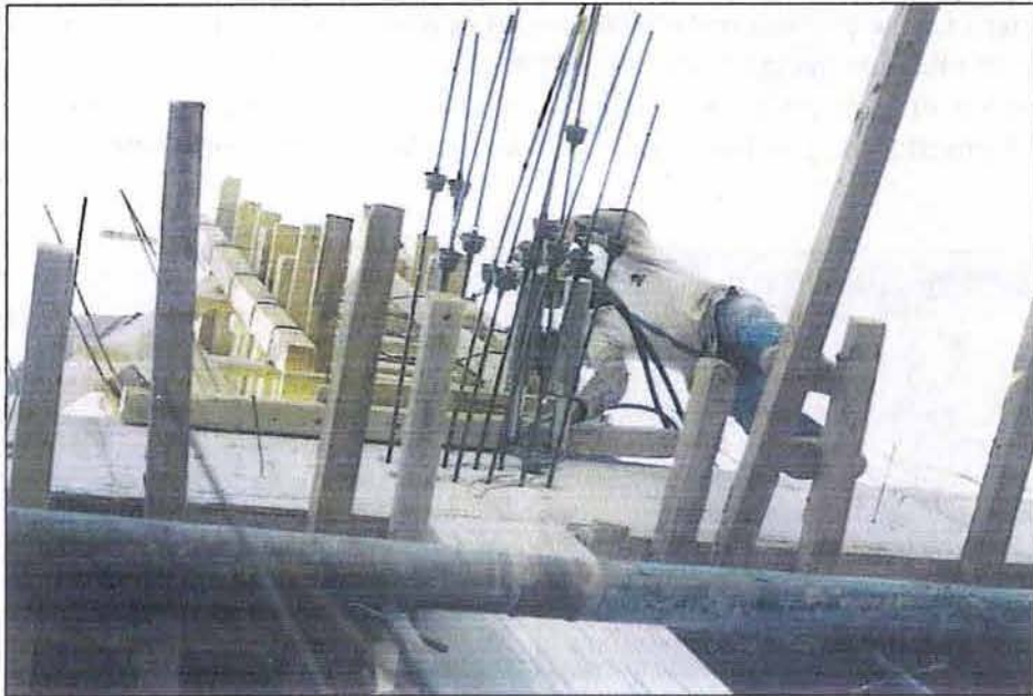
Figura 6.18. Instalación del gato de preesfuerzo en un torón del tendón de preesfuerzo de las traves de la estructura.
