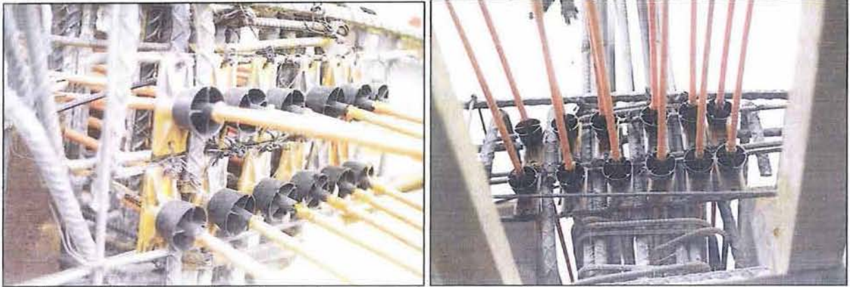
Figura 6.12. Colocación de las anclas monotorón para preesfuerzo de las traves de la estructura.
