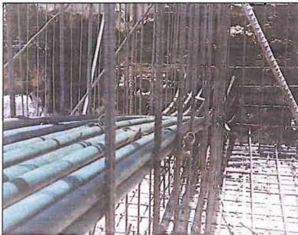
Figura 6.4. Anclajes (fijo) del tendón de preesfuerzo de las contratraves de cimentación.
