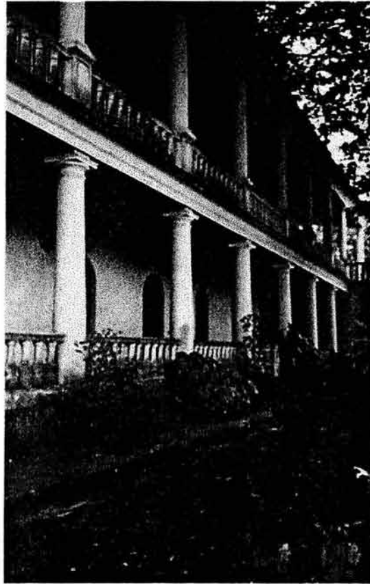
VISTA EXTERIOR DEL PORTICO DE LA EX – HACIENDA LA ORDUÑA
