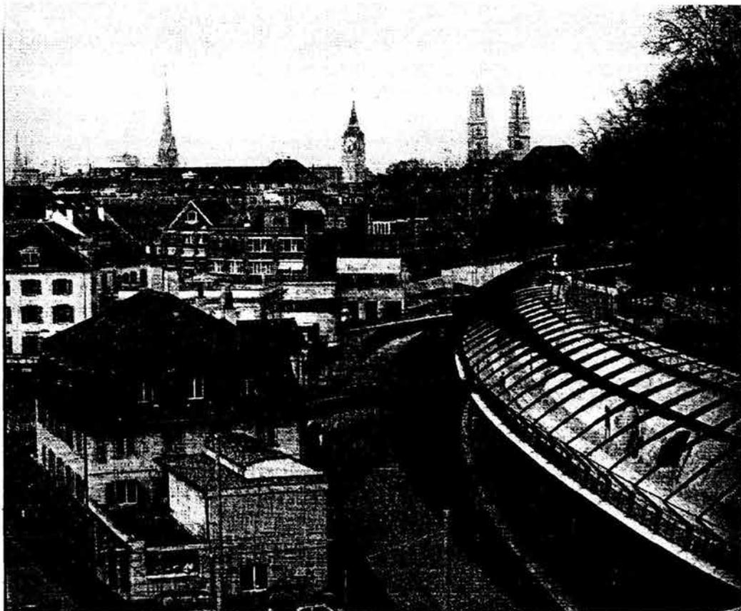
En el nivel siguiente, la zona de las vías queda cubierta por un sistema de marquesinas; la galería porticada que cubre la tercera vía esta constituida por pilares de acero inclinados, con secciones cajón en forma de H, formados por dos planchas cortadas (de unos 110 mm), soldados entre si. sigue la curva del muro de sostenimiento para recuperar la zona verde que perdió el parque al hacer el desmonte de parte de la colina para crear una tercera vía.
